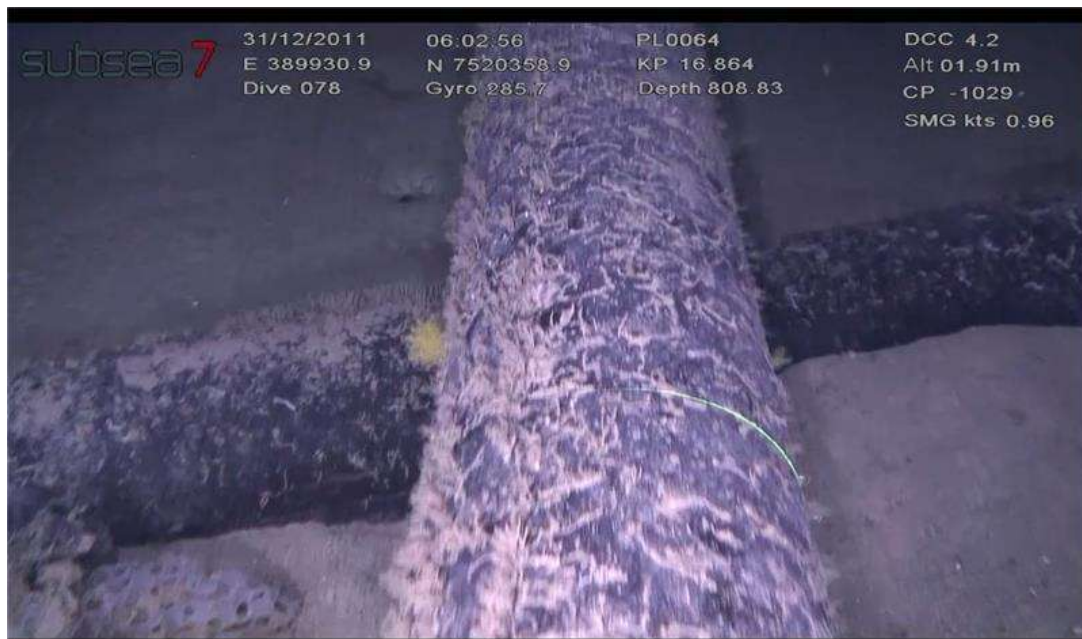
Figura 3-IV - LINHA ABANDONADA (DESCONECTADA) posicionada sob o GA P-18/MIS-MRL-01
