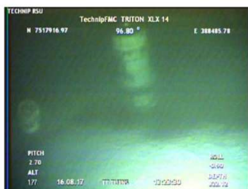
Foto 1 – Estaca de ancoragem do sistema #6 de ancoragem da P-35.
