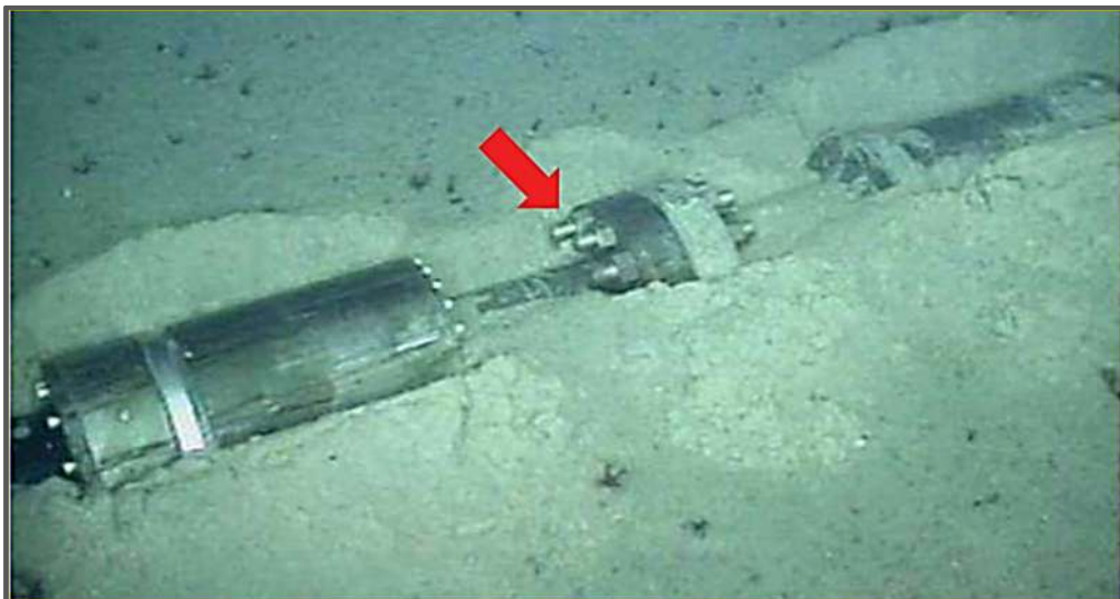
Figura 5.3.2-III - CRF (Conexão Riser-Flowline) de um duto flexível. A seta mostra os estojos responsáveis por estabelecer a conexão flangeada entre os conectores dos tramos flowline e riser.
