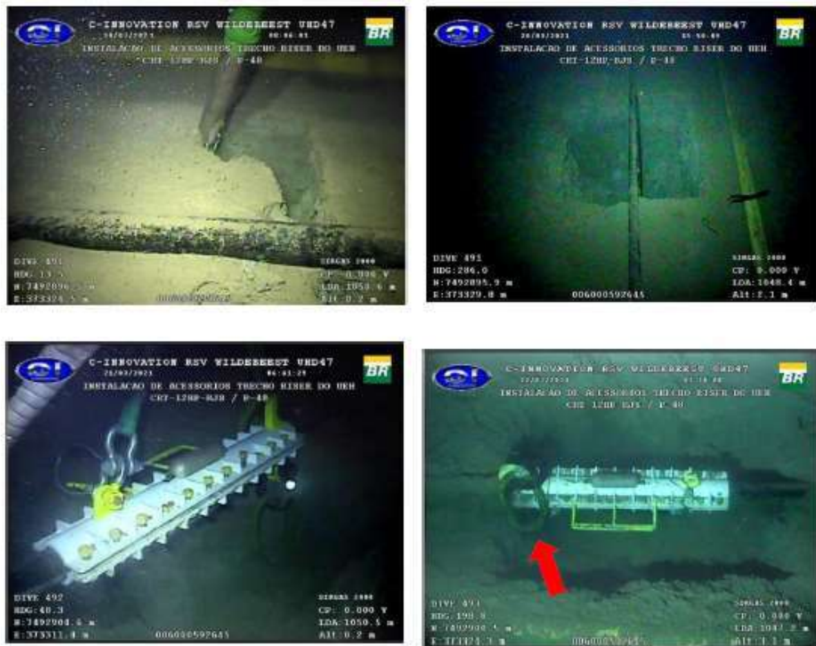
Figura 5.3.2-IX - Fotos mostrando diferentes momentos da operação de preparação (dragagem) e instalação da ferramenta especial de içamento de linhas cortadas em um umbilical. Destaca-se que a ferramenta é descida e posicionada com auxílio do guincho / guindaste da embarcação. A seta vermelha mostra o anel no qual a lingada proveniente da PLSV será conectada para realizar o içamento da linha para a embarcação, permitindo o seu recolhimento.
