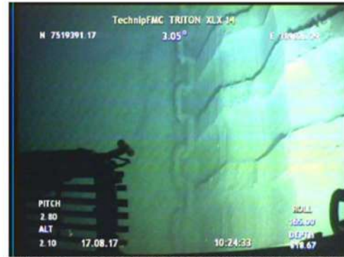
Foto 16 – Trecho da amarra do sistema #8 dentro de formação de vala de aproximadamente 2m de profundidade
