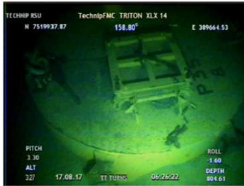
Foto 15 – Estaca de ancoragem do sistema #8 de ancoragem da P-35.
