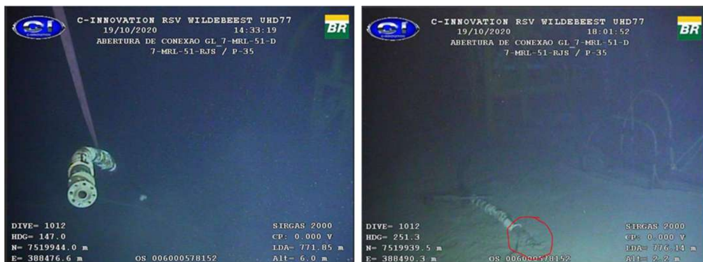
Figura 3.3-I - Duto de gas lift do poço 7-MRL-51-RJS. À esquerda, movimentação do duto aberto; à direita, duto aberto posicionado sobre leito marinho.
