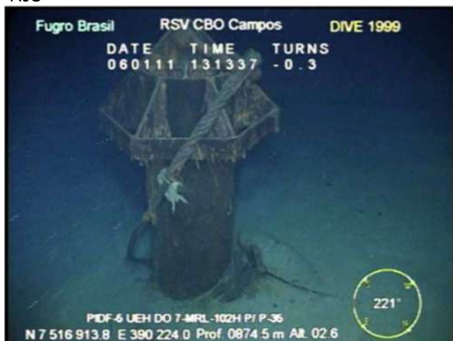
Figura 3.3-V – Estaca usada na ancoragem dos dutos do 7-MRL-102H-RJS
