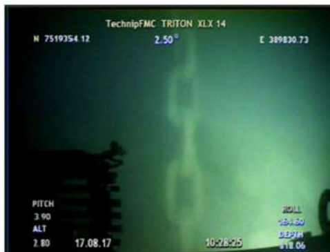
Foto 17 – Início do TDP do sistema #8 de ancoragem da P-35
