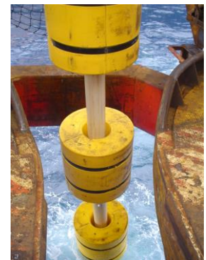
Figura 5.VI: Sequência de fotos ilustrando a etapa de instalação de flutuadores (riser em pliant wave).
