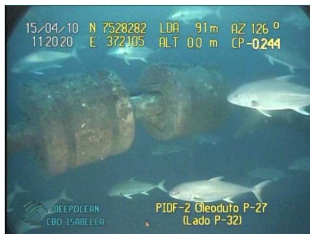
Figura 5.XII: Corcova com flutuadores da configuração pliant wave do riser do Oleoduto P-27/P-32. Foto tirada durante inspeção realizada em 2010.
