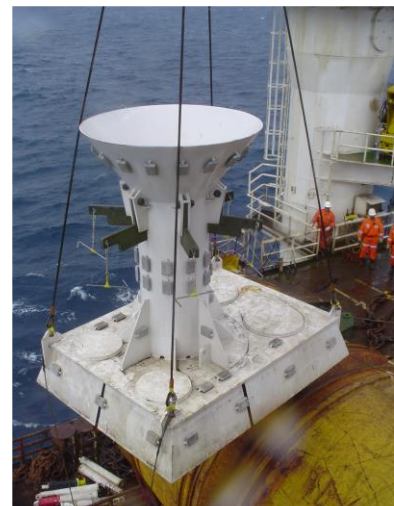
Figura 5.V: Sequência de fotos ilustrando a etapa de instalação de um peso morto (riser em pliant wave).
