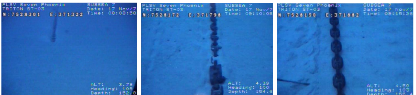
Figura 6.2.3-IV: Fotos tiradas durante inspeção da linha de ancoragem #3, em 2017, mostrando (da esquerda para a direita): posição da âncora, amarra apoiada no leito marinho e região do TDP.
