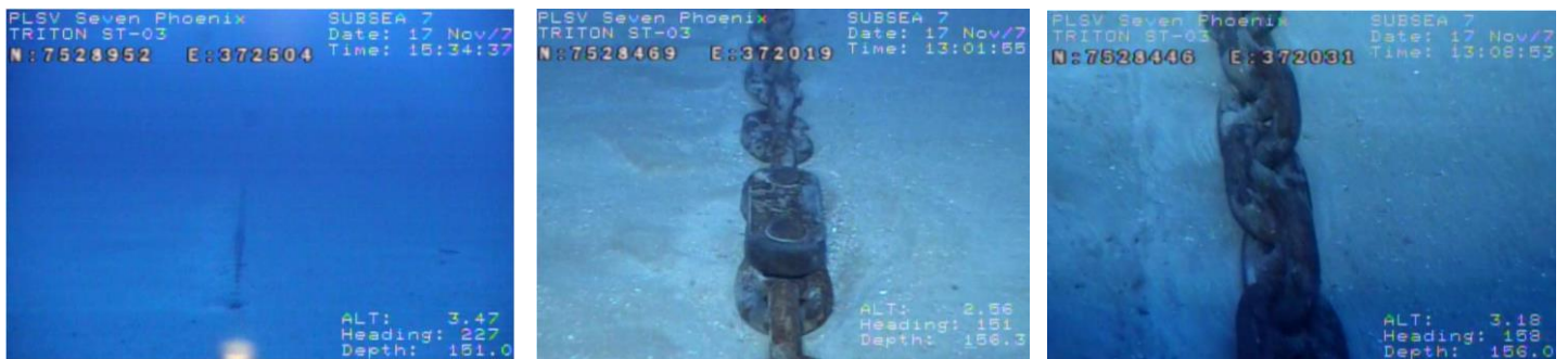
Figura 6.2.3-III: Fotos tiradas durante inspeção da linha de ancoragem #2, em 2017, mostrando (da esquerda para a direita): posição da âncora, amarra apoiada no leito marinho e região do TDP.
