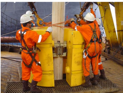
Figura 5.VI: Sequência de fotos ilustrando a etapa de instalação de flutuadores (riser em pliant wave).
