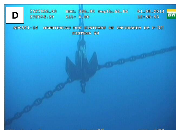
Figura 9.1.8-I: A foto A ilustra o ponto de conexão entre o cabo de aço e a amarra de fundo (a qual será içada até a superfície), enquanto as fotos B, C e D mostram a sequência de conexão da garateia à linha de ancoragem (trecho suspenso).
