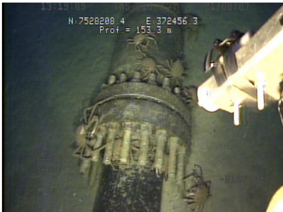
Figura 5.XIV: Conexão “riser flexível” x “flowline rígido” do Oleoduto P-19/P-32 Sul. Foto tirada durante inspeção realizada em 2007.
