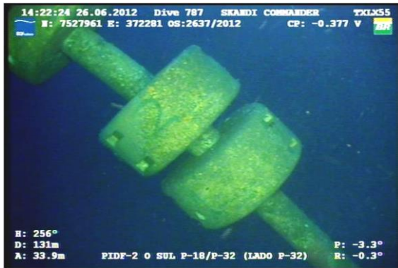
Figura 5.X: Flutuadores instalados no riser do Oleoduto P-18/P-32 Sul. As fotos, tiradas durante inspeção realizada em 2012, ilustram a parte final (foto esquerda) e superior (foto direita) da corcova da configuração pliant wave.
