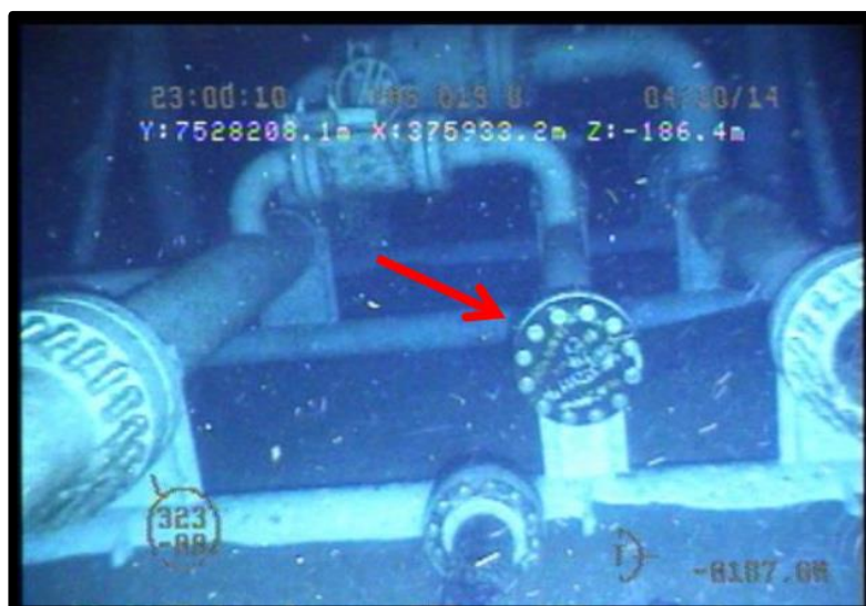
Figura 9.1.3-I: Ilustração de instalação de flange cego (indicado pela seta vermelha) que será realizada nos MIS-MRL-1 e MIS-MRL-2.
