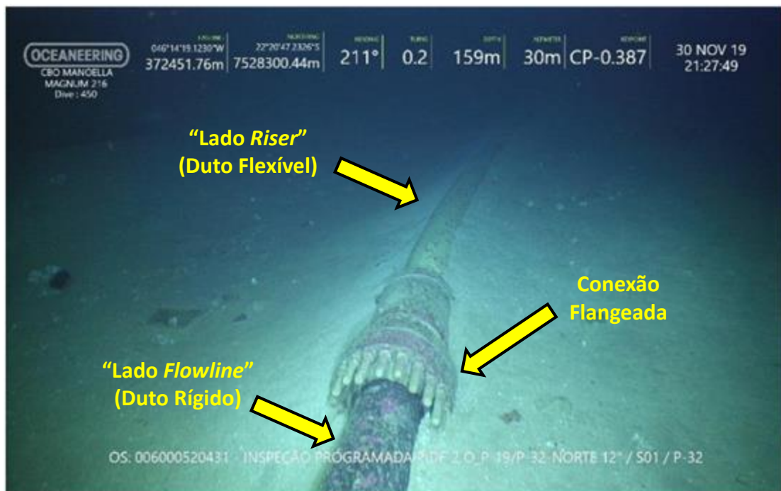
Figura 5.XIII: Trecho de duto flexível parcialmente soterrado (conexão com duto rígido) identificado durante inspeção do riser do Oleoduto P-19/P-32 Norte, realizada em 2019.
