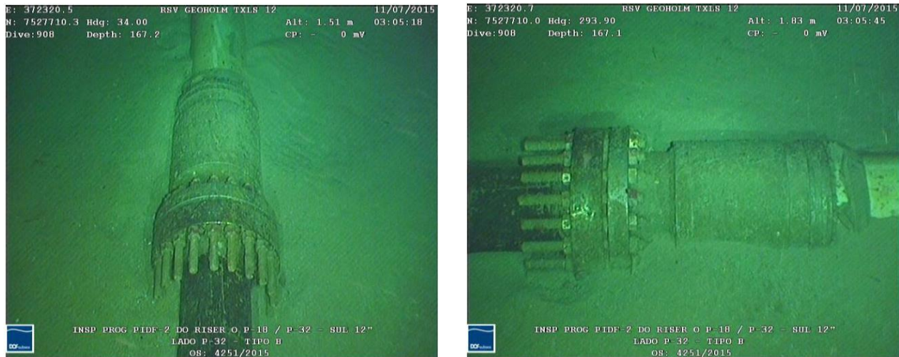
Figura 5.XV: Conexão “riser flexível” x “flowline rígido” do Oleoduto P-18/P-32 Sul. Fotos tiradas durante inspeção realizada em 2015.
