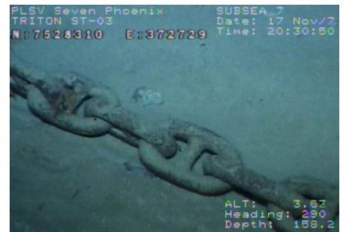
Figura 6.2.3-IX: Fotos tiradas durante inspeção da linha de ancoragem #8, em 2017, mostrando (da esquerda para a direita): posição da âncora, amarra soterrada no leito marinho e região do TDP.
