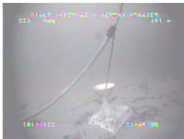
Figura 5.VIII: Peso morto do sistema pliant wave do riser do Oleoduto P-18/P-32 Norte. Foto tirada durante inspeção realizada em 2005.
