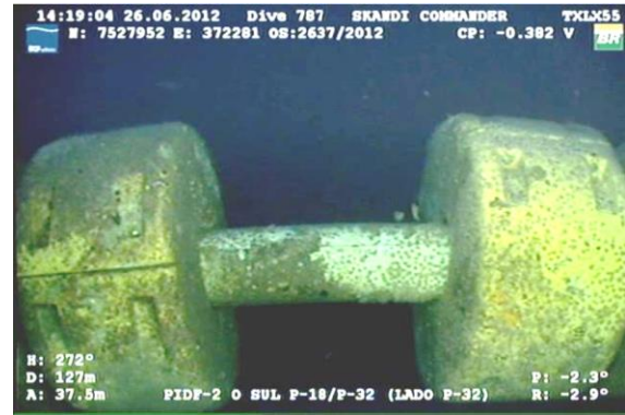
Figura 5.X: Flutuadores instalados no riser do Oleoduto P-18/P-32 Sul. As fotos, tiradas durante inspeção realizada em 2012, ilustram a parte final (foto esquerda) e superior (foto direita) da corcova da configuração pliant wave.
