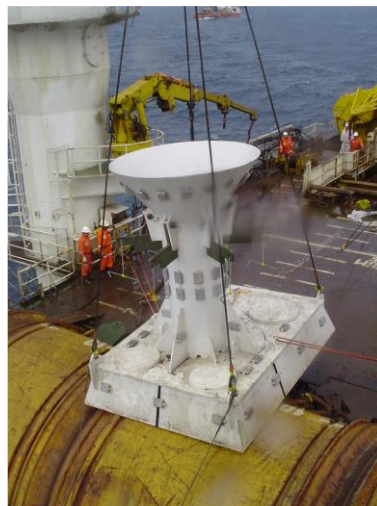
Figura 5.V: Sequência de fotos ilustrando a etapa de instalação de um peso morto (riser em pliant wave).
