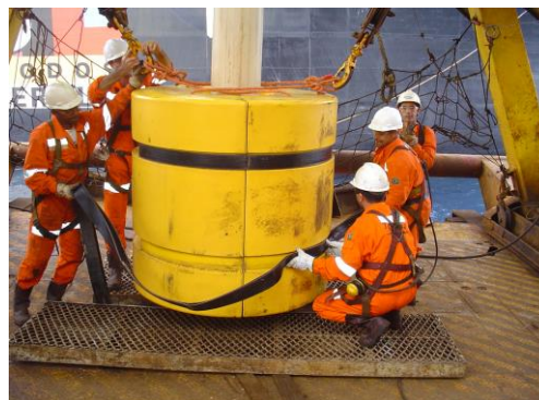
Figura 5.VI: Sequência de fotos ilustrando a etapa de instalação de flutuadores (riser em pliant wave).
