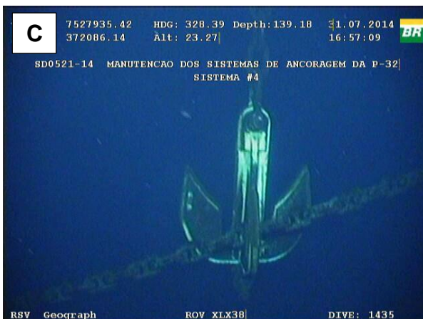
Figura 9.1.8-I: A foto A ilustra o ponto de conexão entre o cabo de aço e a amarra de fundo (a qual será içada até a superfície), enquanto as fotos B, C e D mostram a sequência de conexão da garateia à linha de ancoragem (trecho suspenso).
