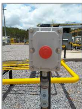
Imagem 4: Exemplo de botoeira de emergência instalada em campo.
