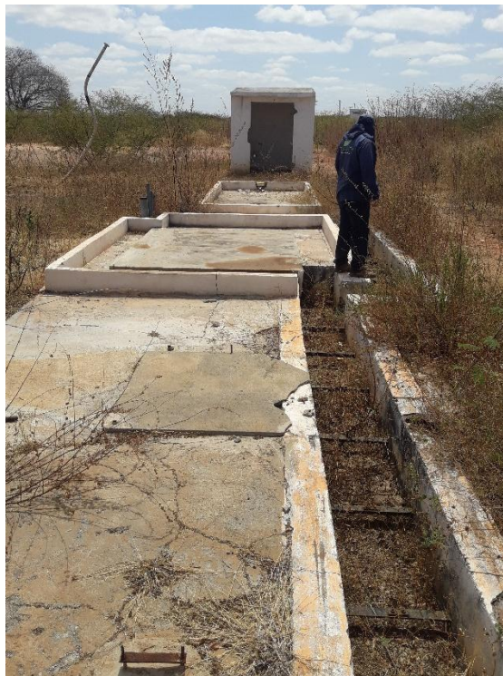
Figura 11: Estruturas de alvenaria que devem ser desmobilizadas do poço 1-POTI-02-RN.
