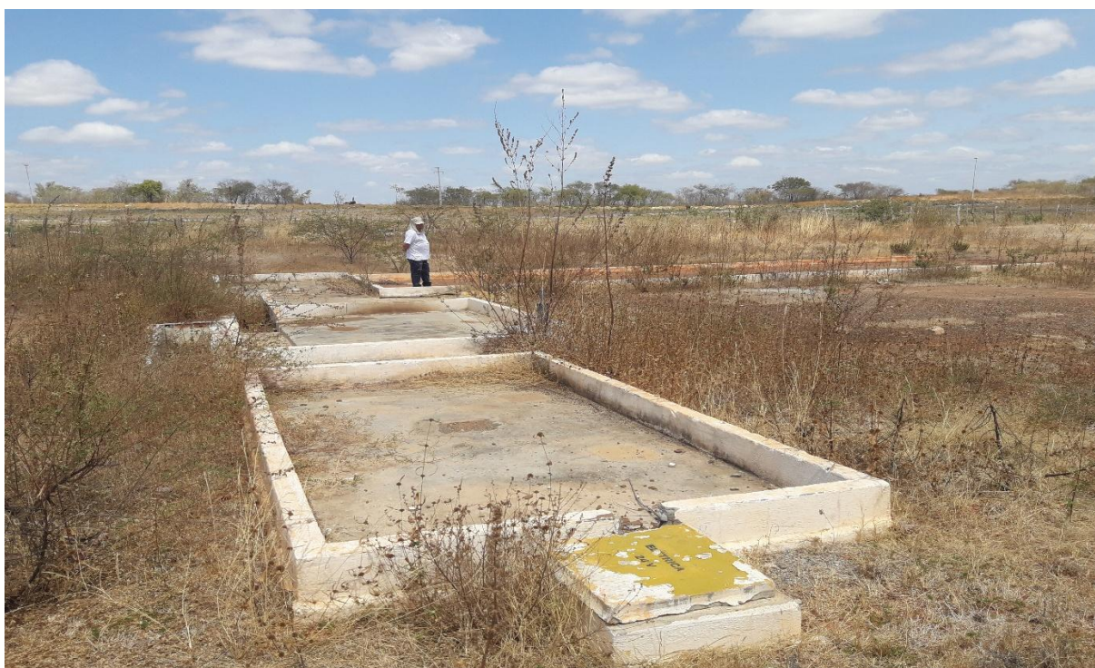
Figura 10: Bacias de Contenção e Rampa de carregamento do poço 1-POTI-02-RN.
