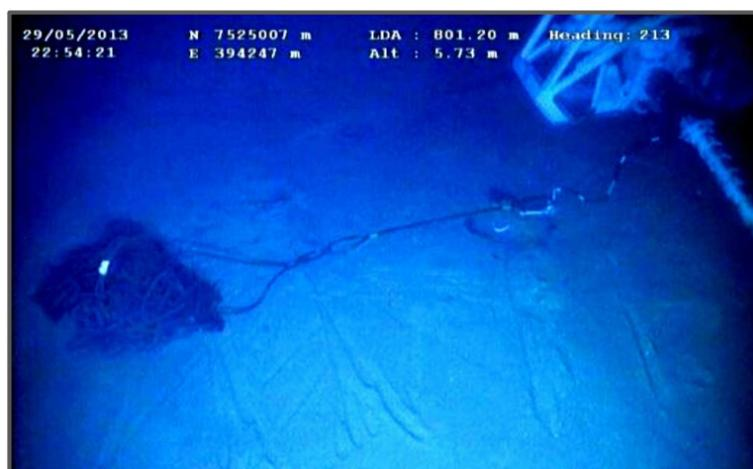
**Figura 5.3.2-VII:** Imagem de ancoragem de duto flexível por meio de cacho de amarra posicionado no leito marinho.
