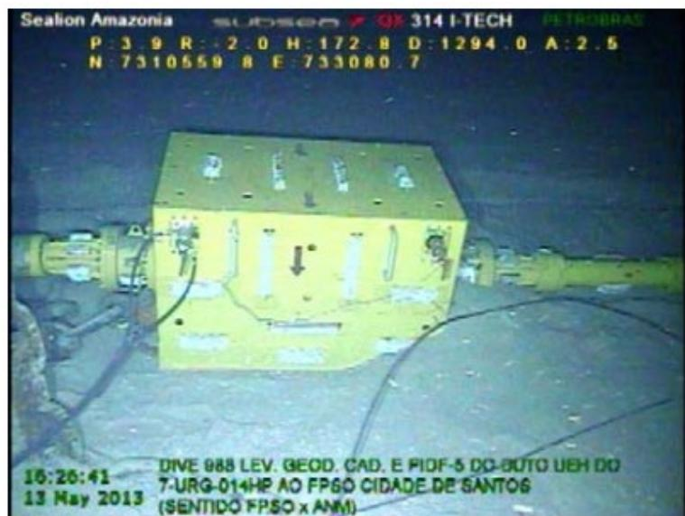
*Figura 5.3.2-VI: caixa de Junção (CJ), com HFLs (Hydraulic Flying Leads) para açãoamento da ESDV.*
