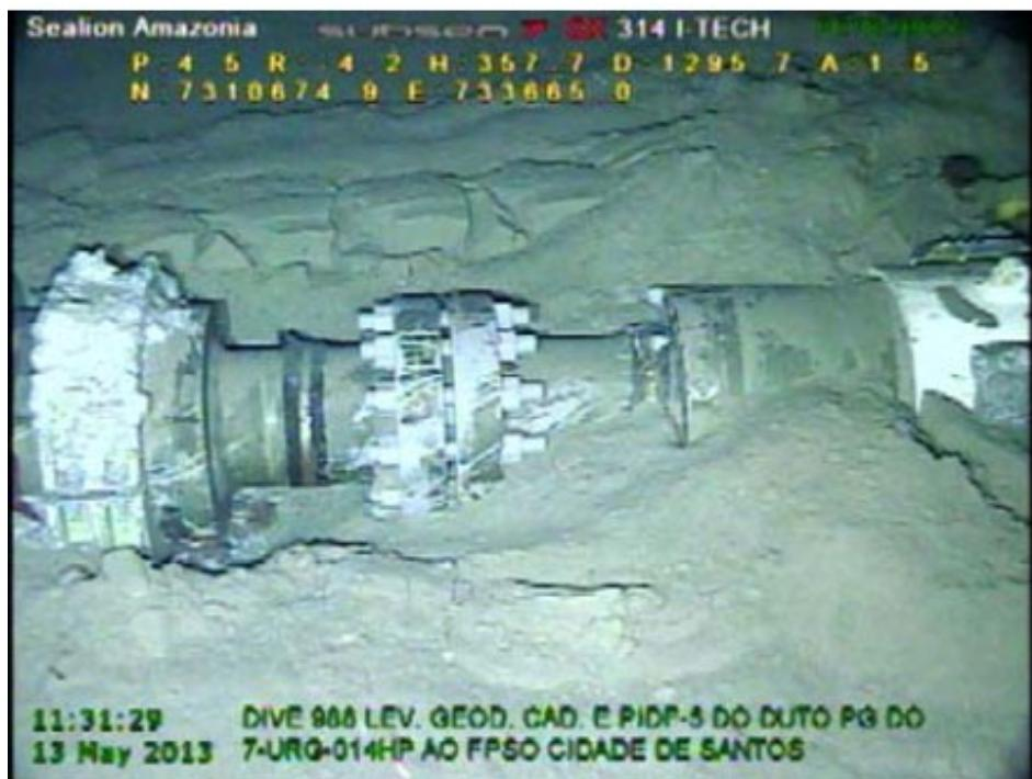
**Figura 5.3.2-IV** – Conexão flangeada entre tramos de um duto flexível (exemplo acima de uma conexão entre tramos flowlines do duto de PG do poço URG-14).
