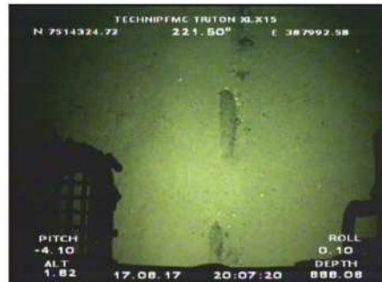
Foto 2 – Trecho da amarra do sistema #2 soterrado
