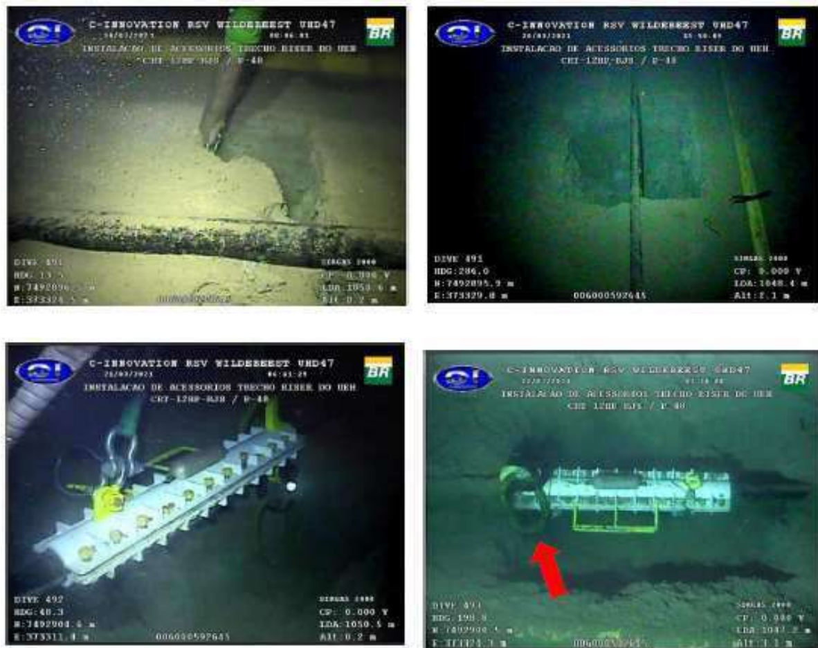
Figura 5.3.2-IX - Fotos mostrando diferentes momentos da operação de preparação (dragagem) e instalação da ferramenta especial de içamento de linhas cortadas em um umbilical. Destaca-se que a ferramenta é descida e posicionada com auxílio do guincho / guindaste da embarcação. A seta vermelha mostra o anel no qual a lingada proveniente do PLSV será conectada para realizar o içamento da linha para a embarcação, permitindo o seu recolhimento.
