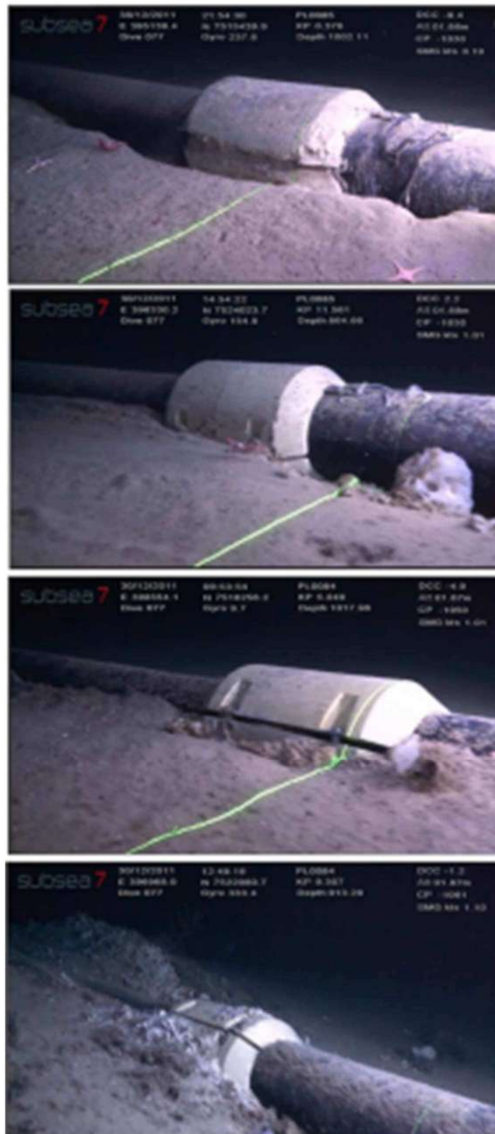
Figura 4.b-III - Anodos Soterrados
