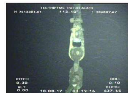
Foto 12 – Conexão entre fim da amarra de fundo e início do cabo do sistema #8 de ancoragem da P-37
