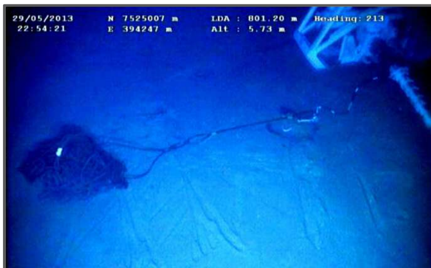
Figura 5.3.2-IV - Imagem de ancoragem de duto flexível por meio de cacho de amarra posicionado no leito marinho
