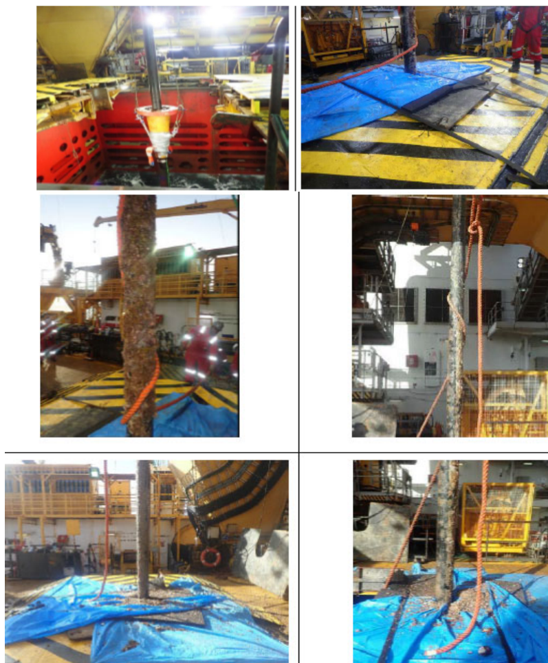
Figura 5.2.4.10 - Limpeza bioincrustação do Riser do elevador de gás Bijupira
