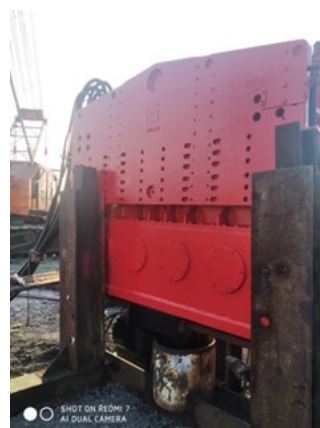
Figura 25: Gabarito para instalação das estacas pranchas.
