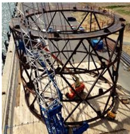
Figura 25: Gabarito para instalação das estacas pranchas.
