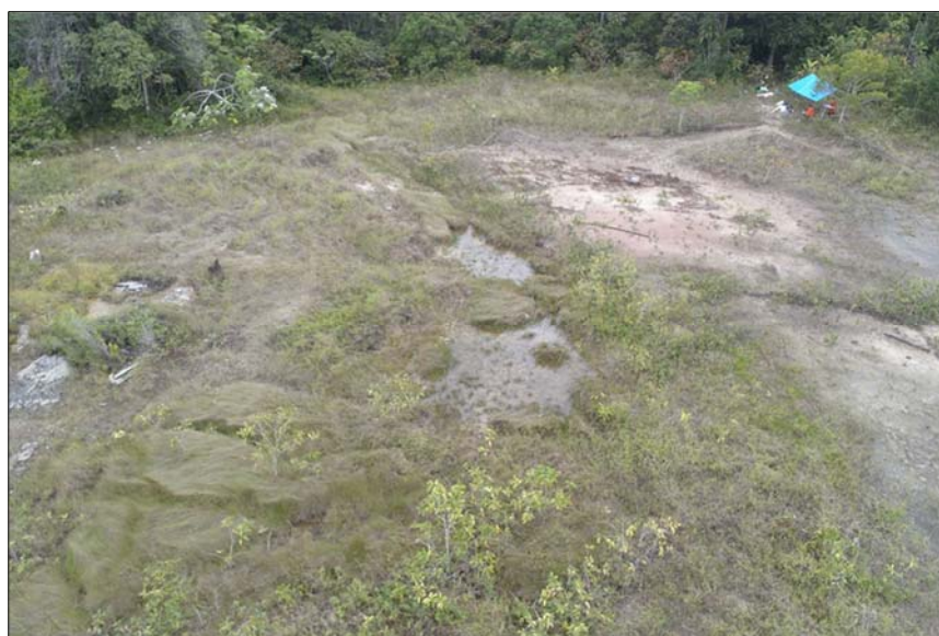
Figura 48: Acúmulo de água no centro da locação e processos erosivos superficiais da locação do poço 1-IP-1-AM.
