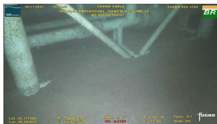
Figura L-VI - Assoreamento parcial do contraventamento inferior do MIS-MRL-2.
