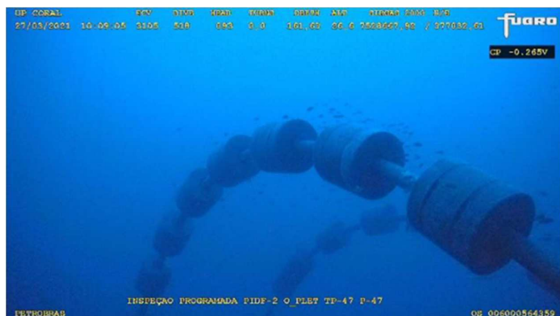
Figura 5.2-VII: Corcova com flutuadores da configuração Pliant Wave do riser do Oleoduto Norte (O_PLET "T"/P-47). Foto tirada durante inspeção realizada em 2021.
