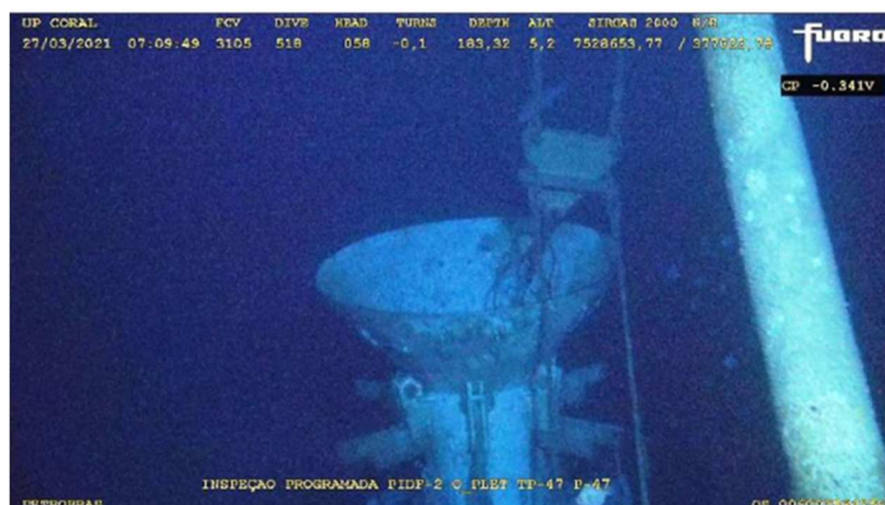
Figura 5.2-VI: Peso morto do sistema Pliant Wave do riser do Oleoduto Norte (O_PLET “T”/P-47). Foto tirada durante inspeção, realizada em 2021, na P-47
