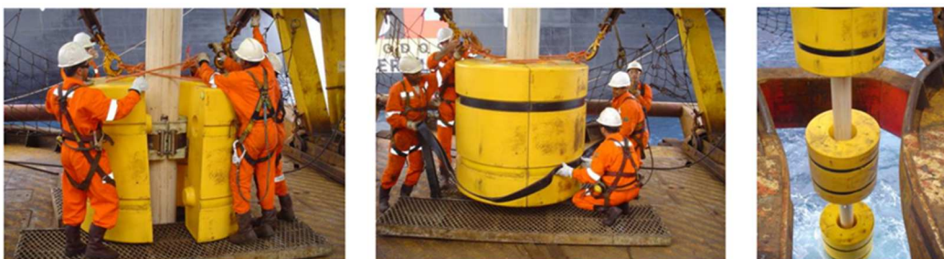
Figura 5.2-IV: Exemplo da etapa de instalação de flutuadores (riser em Pliant Wave)
