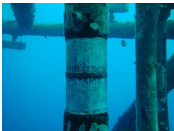
Figura 3-5: Detalhe de fixação dos risers rígidos
