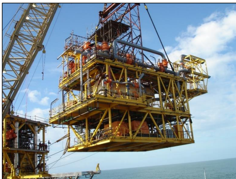
Figura 4: Içamento do Módulo Vent de PMNT-1
