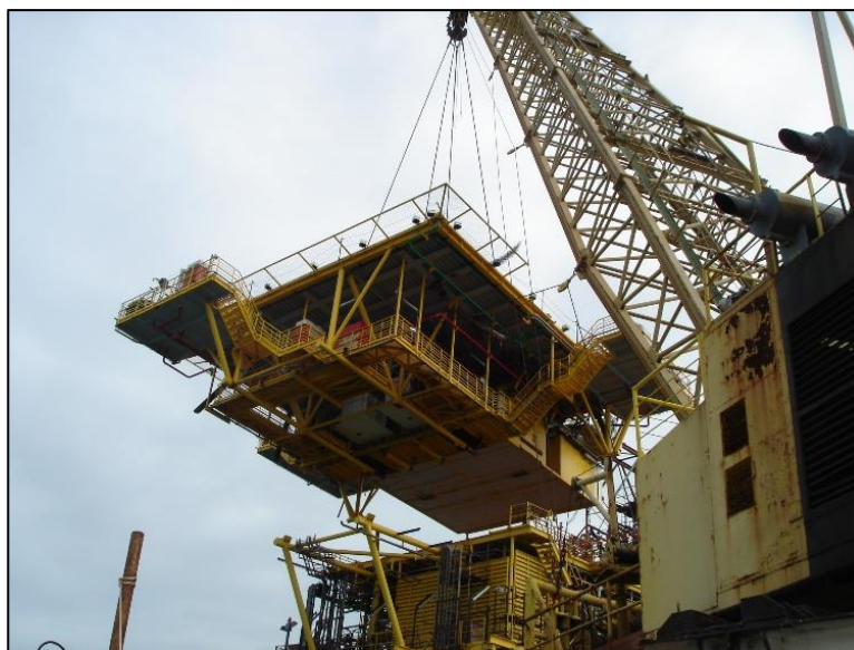
Figura 3: Içamento do módulo Heliponto de PMNT-1
