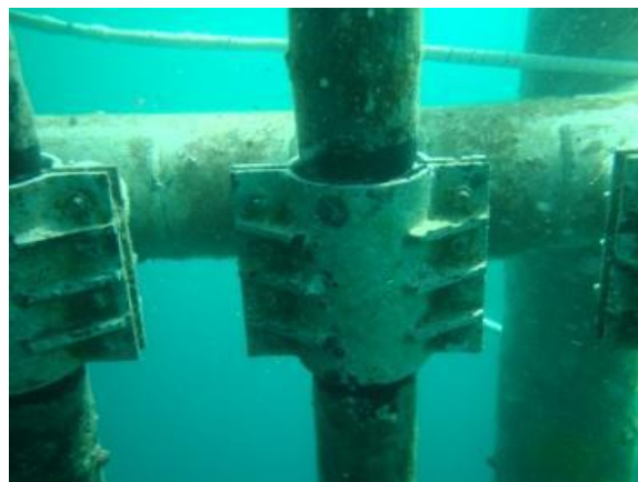
Figura 3-5: Detalhe de fixação dos risers rígidos
