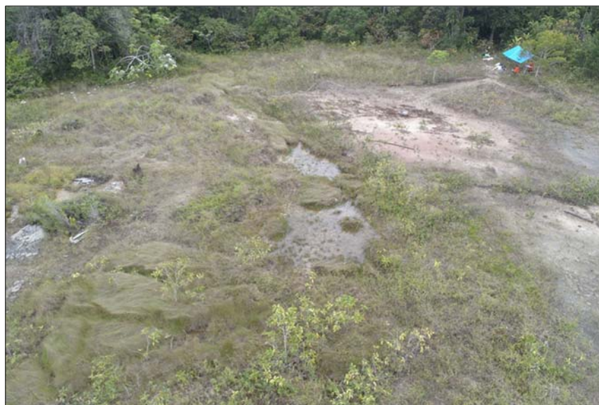
Figura 48: Acúmulo de água no centro da localização e processos erosivos superficiais da localização do poço 1-IP-1-AM.
