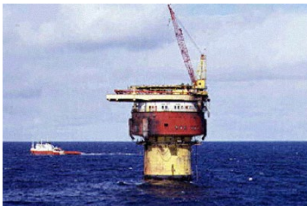
FIGURA 21: PLATAFORMA BRENT SPAR JÁ SEM O TOPSIDE E TENDO A SEÇÃO SUPERIOR CORTADA E LEVANTADA.
