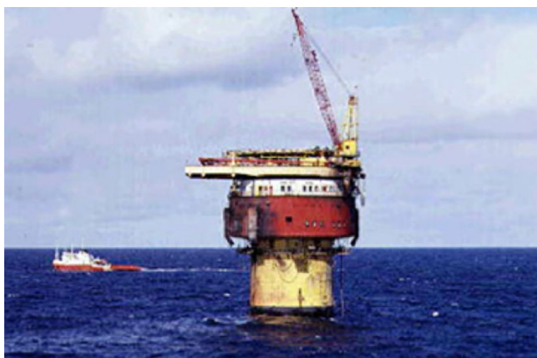
FIGURA 5: PLATAFORMA DO TIPO SPAR.
