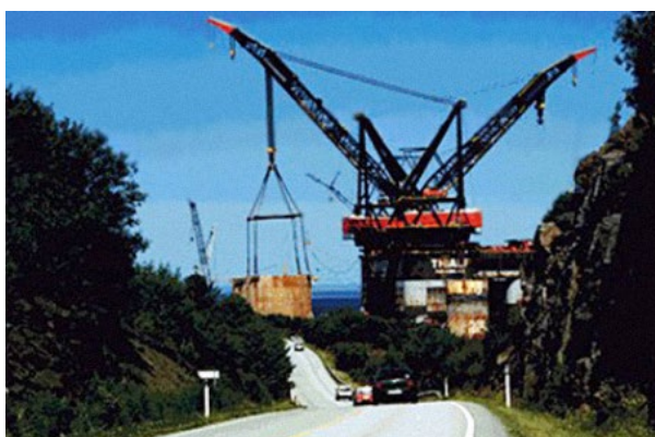
FIGURA 22: INSTALAÇÃO DAS SEÇÕES DA BRENT SPAR NO NOVO LOCAL.
