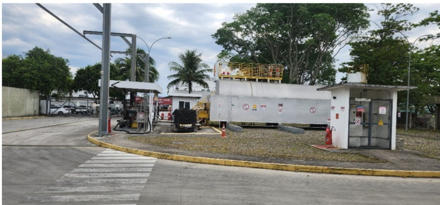
Foto VI.4 - Skid de recebimento/expedição e tanque epicotado de armazenamento de JET A, localizado no PAA da Raízen no Aeroporto de Jacarepaguá/RJ.
