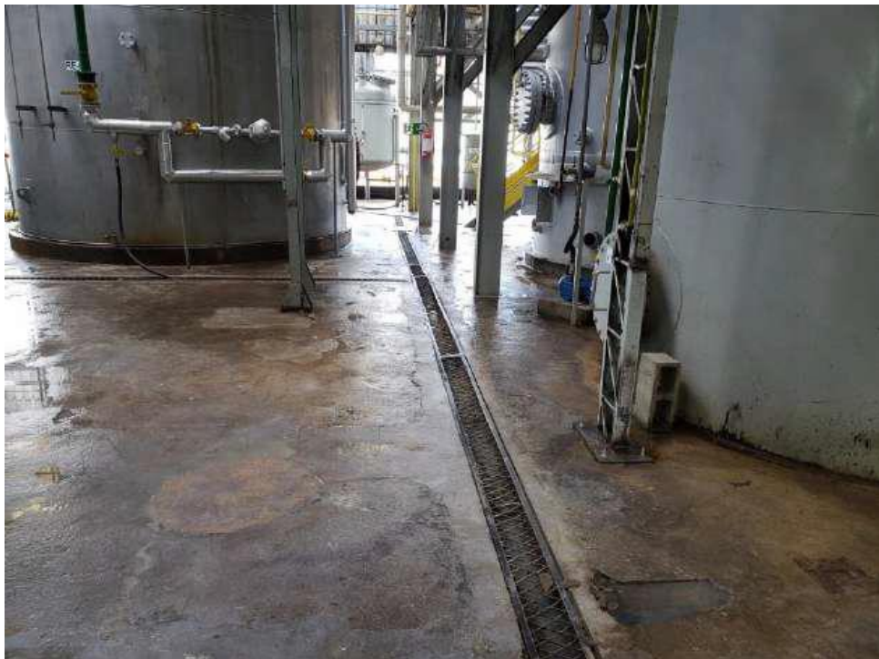
Foto 6: Piso do galpão após a limpeza.
