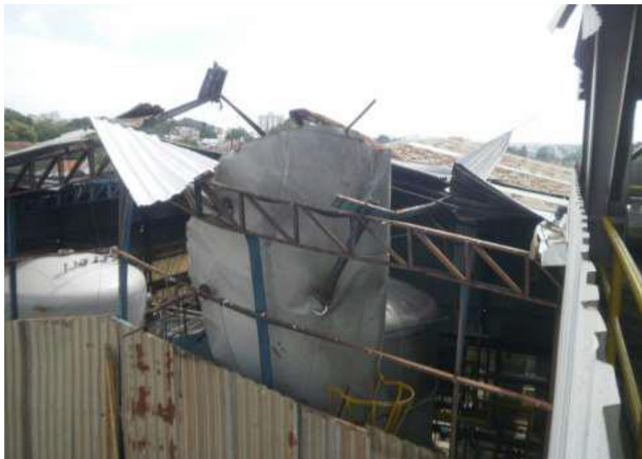
Foto 2: Vista do teto do decantador DC-04 a partir do 2º piso.
