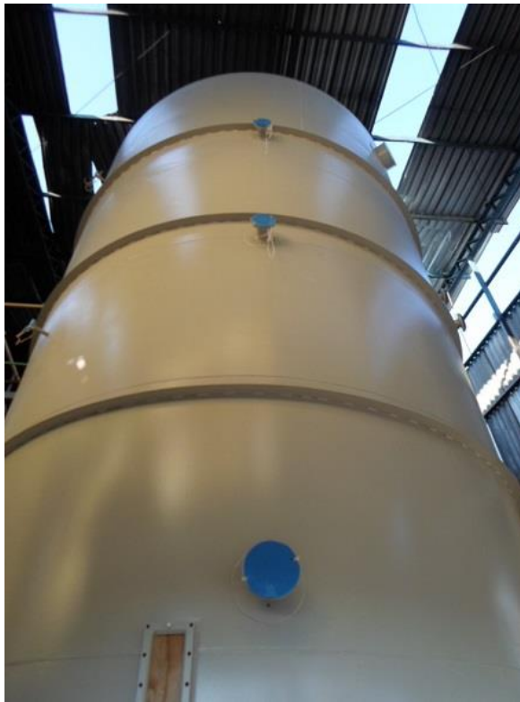
Foto 18: Instalação do novo reator RE-02 sem autorização prévia da ANP.
