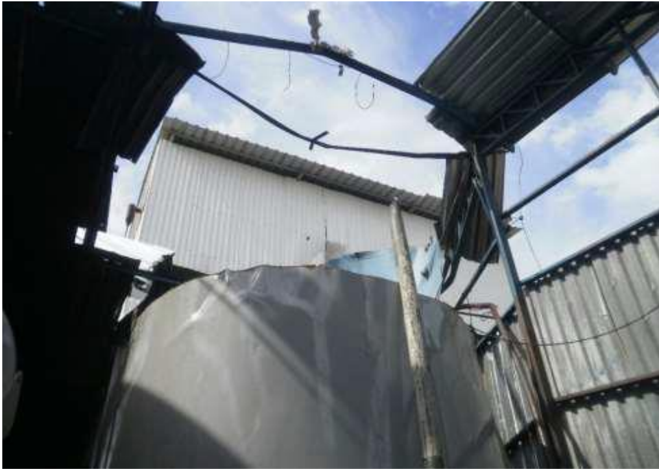
Foto 3: Vista do decantador DC-04 a partir do mezanino interno.
