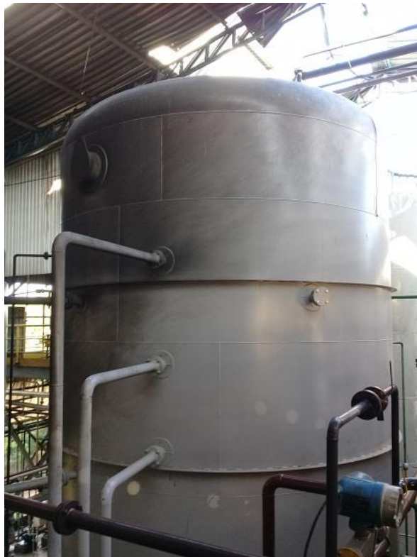
Foto 12: Novo reator RE-03 (que substituiu o antigo RE-03).
