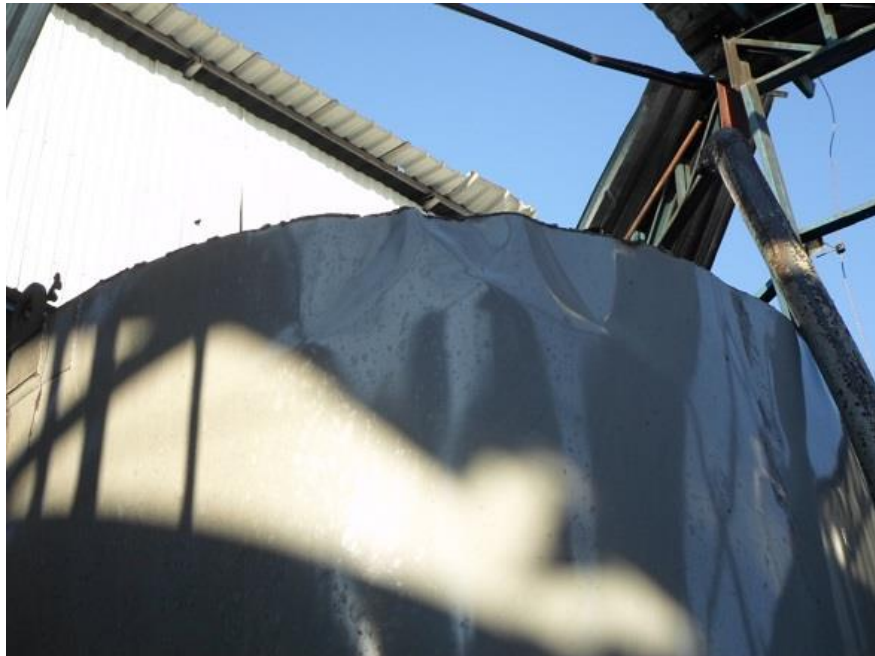
Foto 16: Decantador DC-04 (separação do biodiesel da glicerina).
