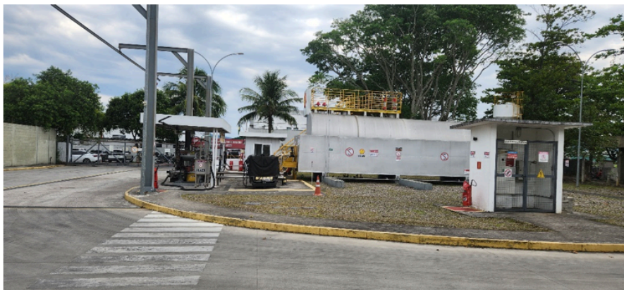
Foto VI.4 - Skid de recebimento/expedição e tanque epicotado de armazenamento de JET A, localizado no PAA da Raizen no Aeroporto de Jacarepaguá/RJ.
