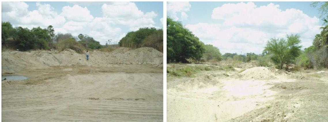
Figura 3.16 – Aspecto do leito do rio Canindé, em que é realizada extração de areia grossa por desmonte mecânico. Município de Canindé.
