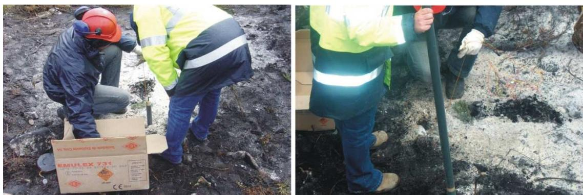
Figura 2.22 – Exemplo do carregamento manual dos furos com explosivos. Fonte: <http://www.visaconsultores.com/htm/desmonte.htm>
