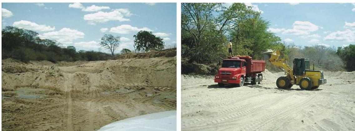
Figura 3.15 – Aspecto do leito do rio Siriema, em que é realizada extração de areia grossa por desmonte mecânico. Município de Caridade.
