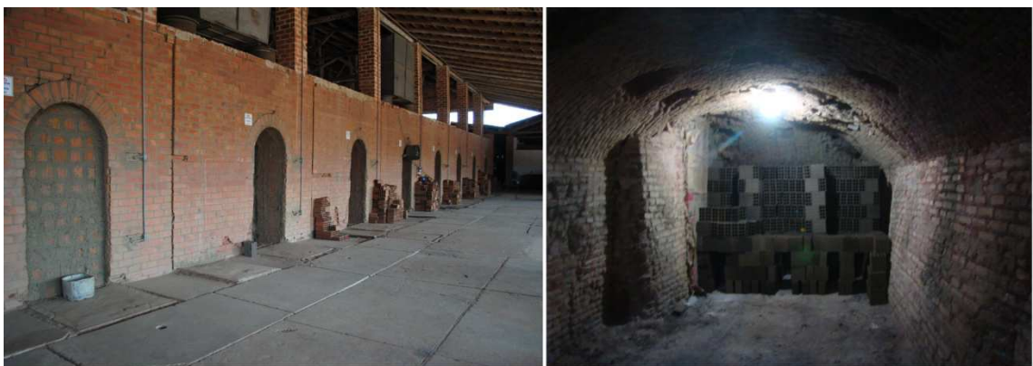
Figura 7.31 – Vista lateral de forno contínuo e interna de uma das câmaras térmicas. Municípios de Russas e Jaguaruana.
