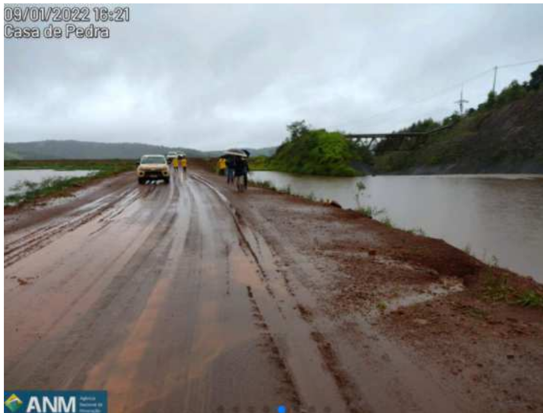
Imagem: Barragem Casa de Pedra – Congonhas/MG
