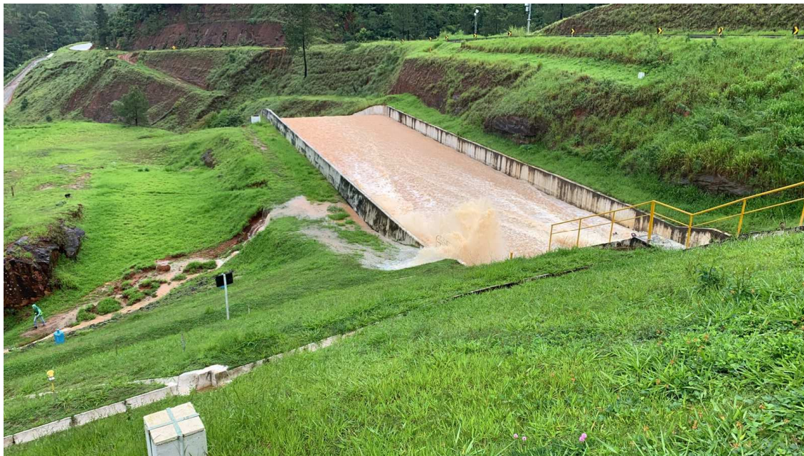
Imagem: Vale – Barragem Santana, Itabira/MG
