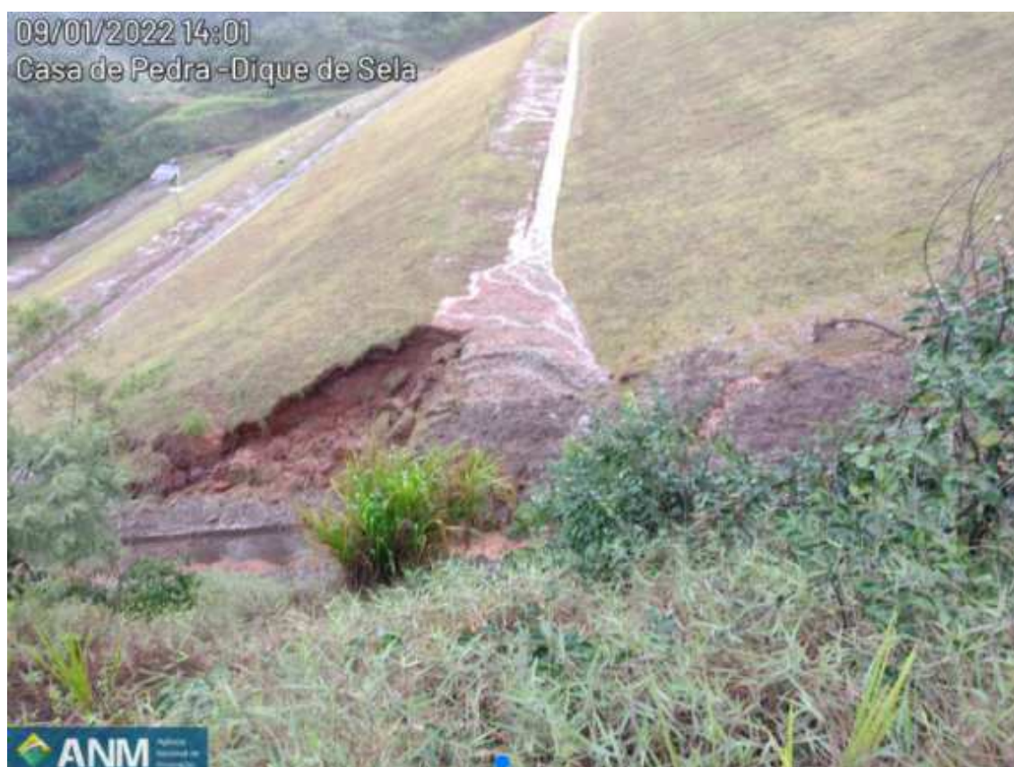
Imagem: Barragem Casa de Pedra – Congonhas/MG
