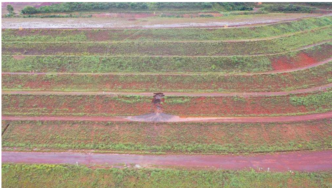
Imagem: Arcelormittal – Barragem de Rejeitos Serra Azul, Nova Lima/MG
