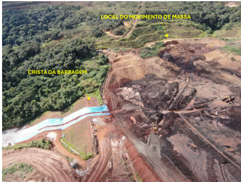
Situação do reservatório escavado à época da inspeção visual com indicações da região onde ocorreu o movimento de massa nas imediações da ombreira direita. Fonte: ANM, 2025.
