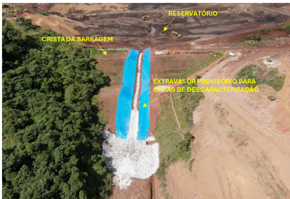
Situação da Barragem Grupo (talude de jusante e reservatório) à época da inspeção visual, com obras de descaracterização em andamento. Fonte: ANM, 2025.
