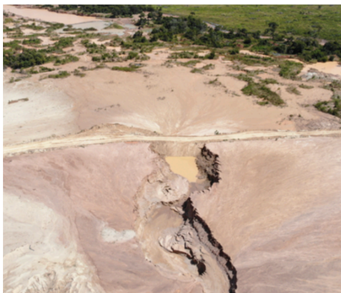
Imagem de “drone” registrada de montante para jusante. O reservatório da barragem em primeiro plano e a área afetada pelo rompimento em segundo plano, com brecha já reparada.
