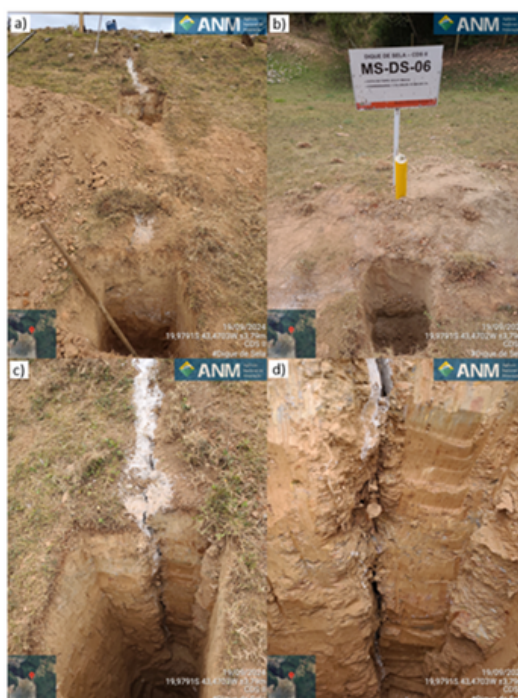
Dique de sela da Barragem CDS II – vista das valas e poços de inspeção das trincas em 19/09/2024
