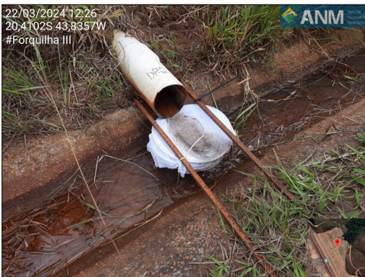
Imagem do dreno coletada pela equipe da ANM em 22 de março de 2024, indicando a presença de sedimentos no aparato instalado pela Vale S.A.
