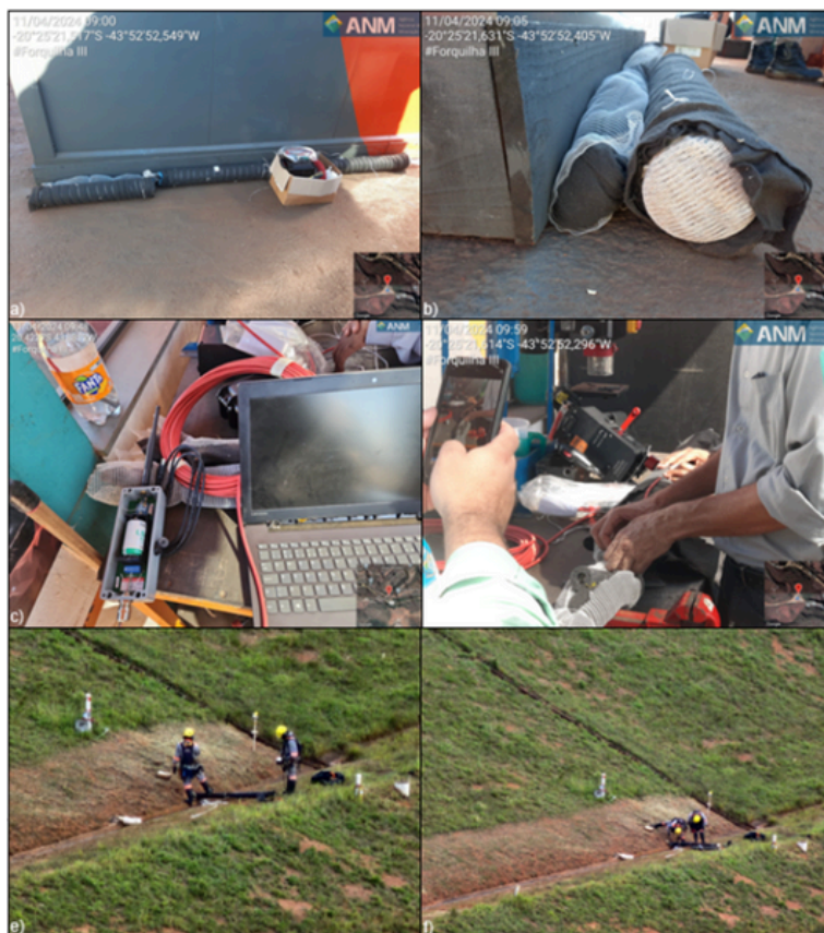
Intervenção do dreno DP-2: a) conjunto modular; b) instalação do piezômetro; c) sistema no interior do dreno
