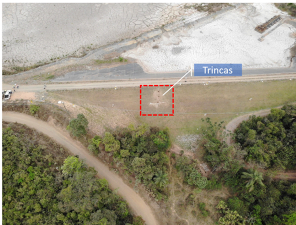
Vista geral da região do talude de jusante do dique de sela afetado pelas trincas em 19/09/2024 (imagem por drone obtida pela equipe da ANM)
