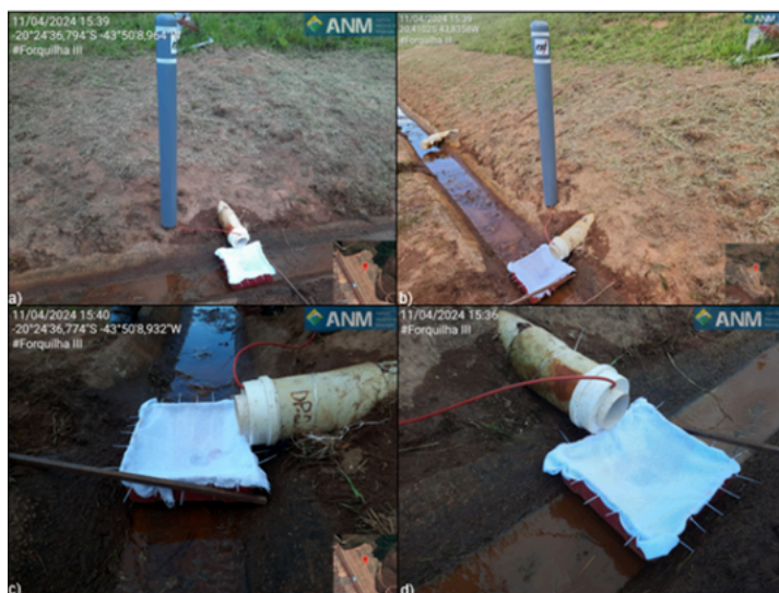
Registros da inspeção realizada horas após a intervenção, sem indícios de novos carregamentos de sedimentos
