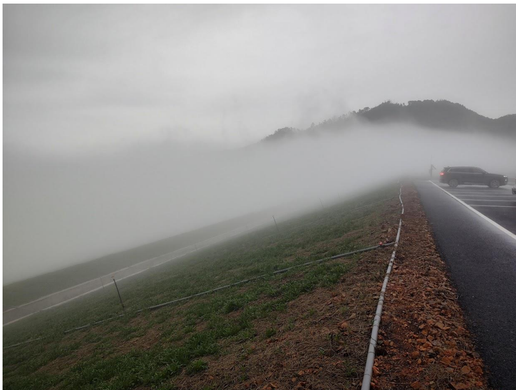
Figura 10: Talude de jusante da Barragem IV visto a partir da crista. As condições meteorológicas dificultaram a visualização completa de jusante da estrutura.
