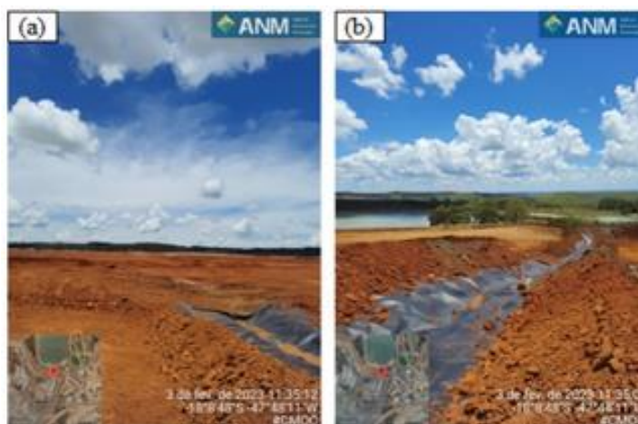
Figura 36: Canal provisório da barragem Unidade I: (a) emboque no reservatório já preenchido; (b) trecho inicial do canal, após o emboque.
