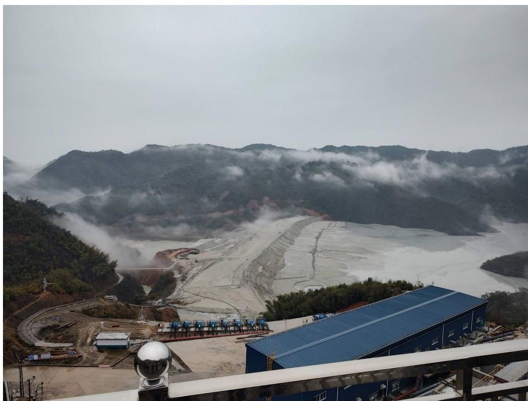
Figura 11: Vista da Barragem V em processo de alteamento.
