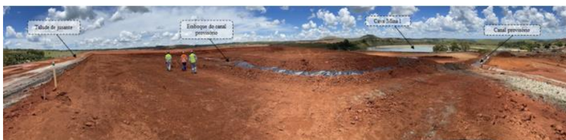
Figura 35: Vista panorâmica do canal provisório na barragem Unidade I
