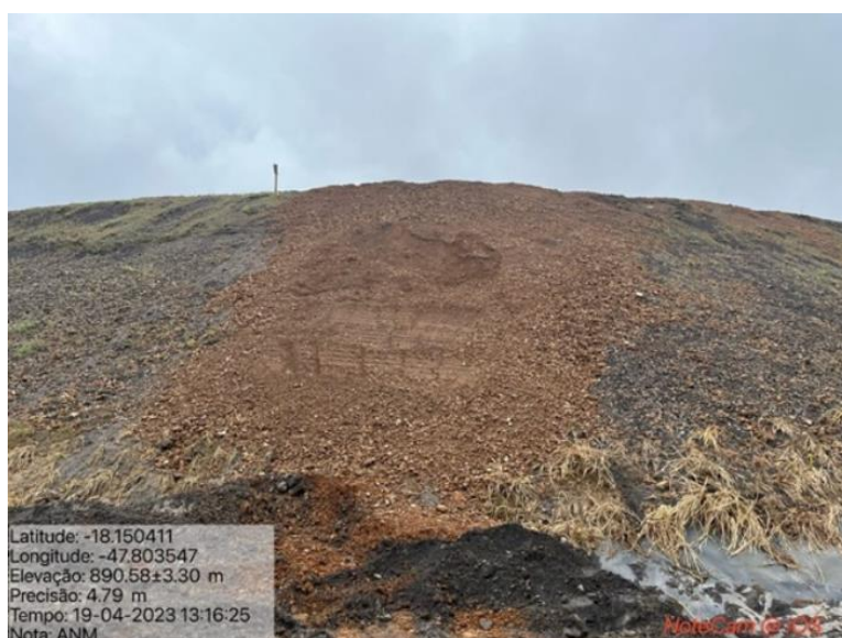
Figura 41: Vista do talude de jusante recuperado.
