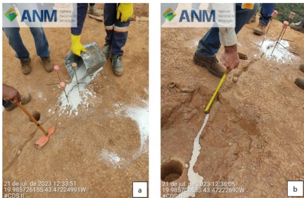
Figura 49: (a) Procedimento de inserção de cal e (b) medição da profundidade da trinca.
