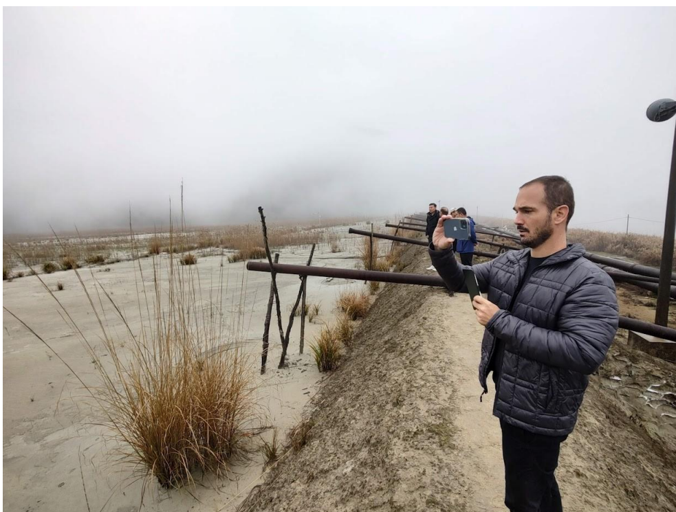
Figura 9: Crista da barragem II, com uma leira com aproximadamente 1,5 metro e 3 de largura.
