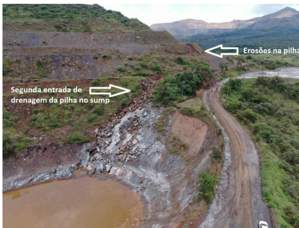
Figura 57: Desemboque da drenagem da pilha da vila no sump próxima a região direta da estrutura.
