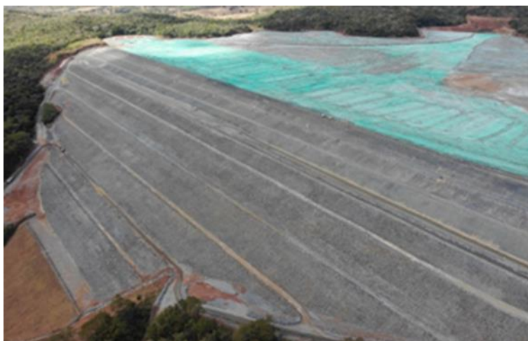
Figura 52: Imagem de Drone da Barragem MSG, vista do talude de jusante e do reservatório (imagem obtida em 11 de julho de 2023)
