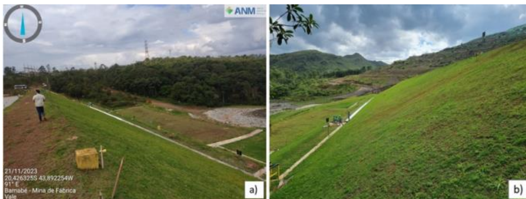
Figura 56: Talude de jusante: (a) vista da ombreira direita (b) vista da ombreira esquerda – barragem Barnabé.
