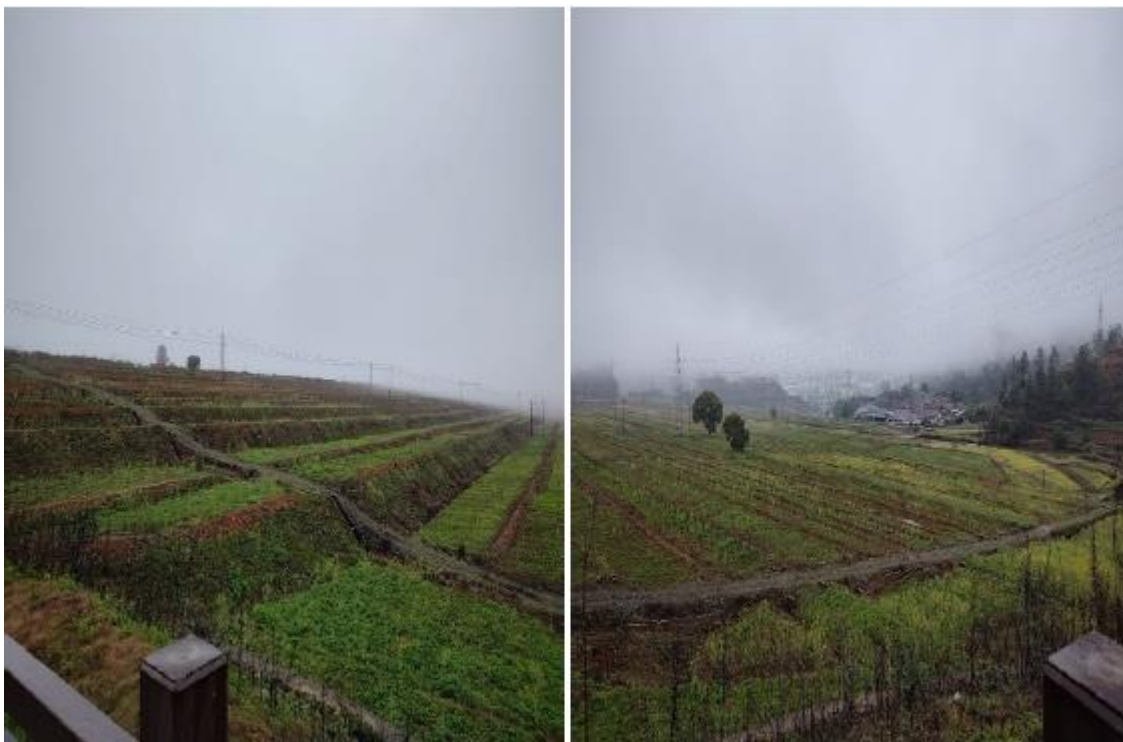
Figura 8: Talude de jusante da barragem I descaracterizada, sendo possível observar a plantação de gramíneas e cultivos rasteiros nas bermas do talude.
