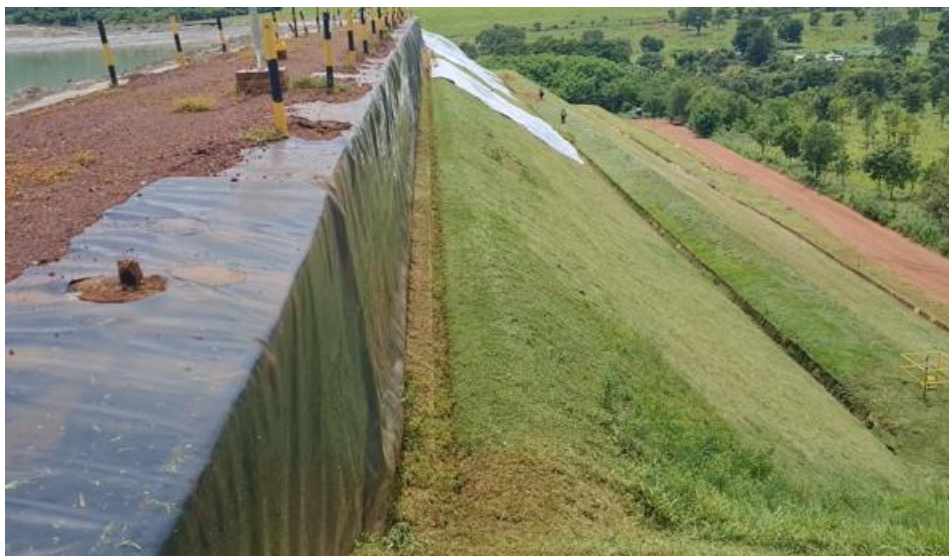
Figura 33: Vista lateral da Barragem 2 a partir da crista.
