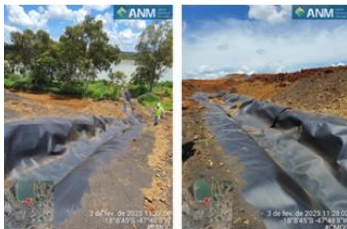
Figura 37: Trecho intermediário do canal provisório da barragem Unidade I.
