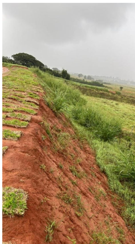
Figura 8: Talude de jusante.
