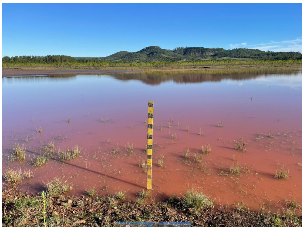
Figura 1: Nível d'água no reservatório, 1,5m abaixo da cota da crista (Fonte: Companhia Brasileira do Cobre).
