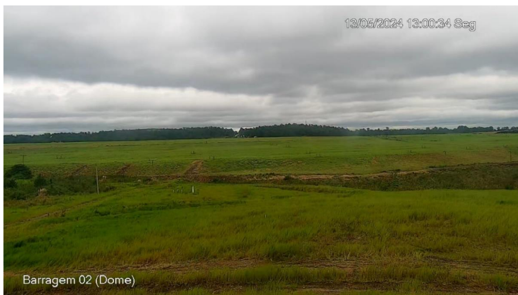
Figura 2 Vista da Barragem Bacia da Mina do Recreio (Fonte: Copelmi Mineração Ltda.).
