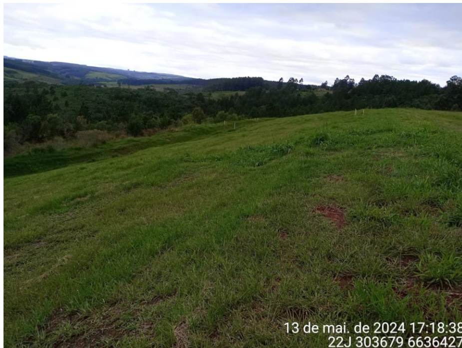
Figura 5: Vista da Barragem Bacia de Finos da Mina do Cerro (Fonte: Copelmi Mineração Ltda.).
