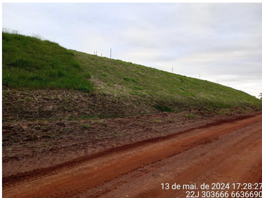
Figura 6: Detalhe do talude com cobertura vegetal da Barragem Bacia de Finos da Mina do Cerro (Fonte: Copelmi Mineração Ltda.).
