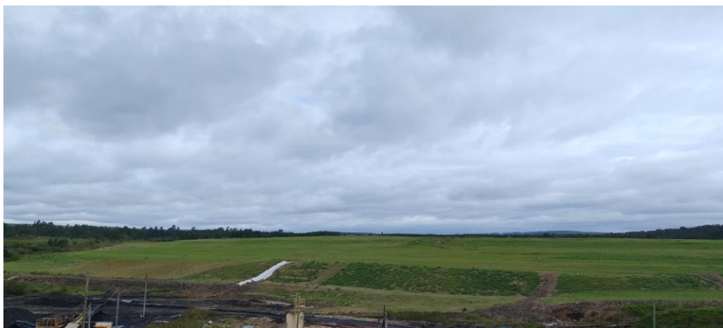
Figura 3: Vista da Barragem Bacia da Mina do Recreio (Fonte: Copelmi Mineração Ltda.).
