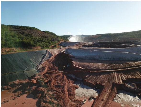
Figura 1 – Vista aérea da pilha após ruptura. Fonte: Jacobina Mineração e Comércio.
