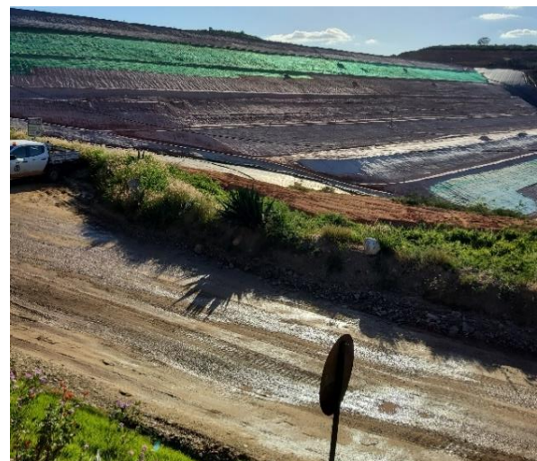
Figura 4 – Vista do talude de jusante da Barragem 02. Fonte: Agência Nacional de Mineração.
