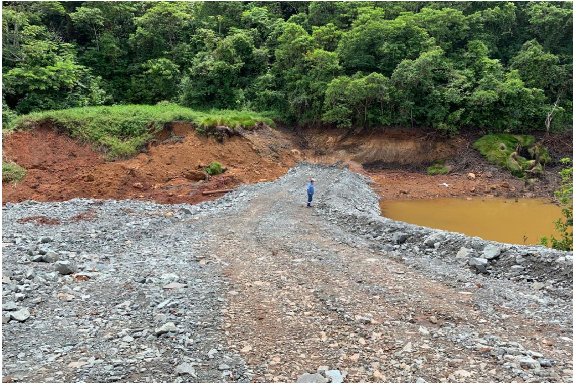
Figura 12: Reconstrução emergencial do barramento rompido.
