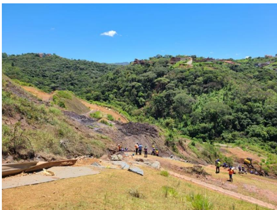
Figura 13: Acompanhamento das obras de correção de anomalia na barragem Casa de Pedra por fiscais da ANM.
