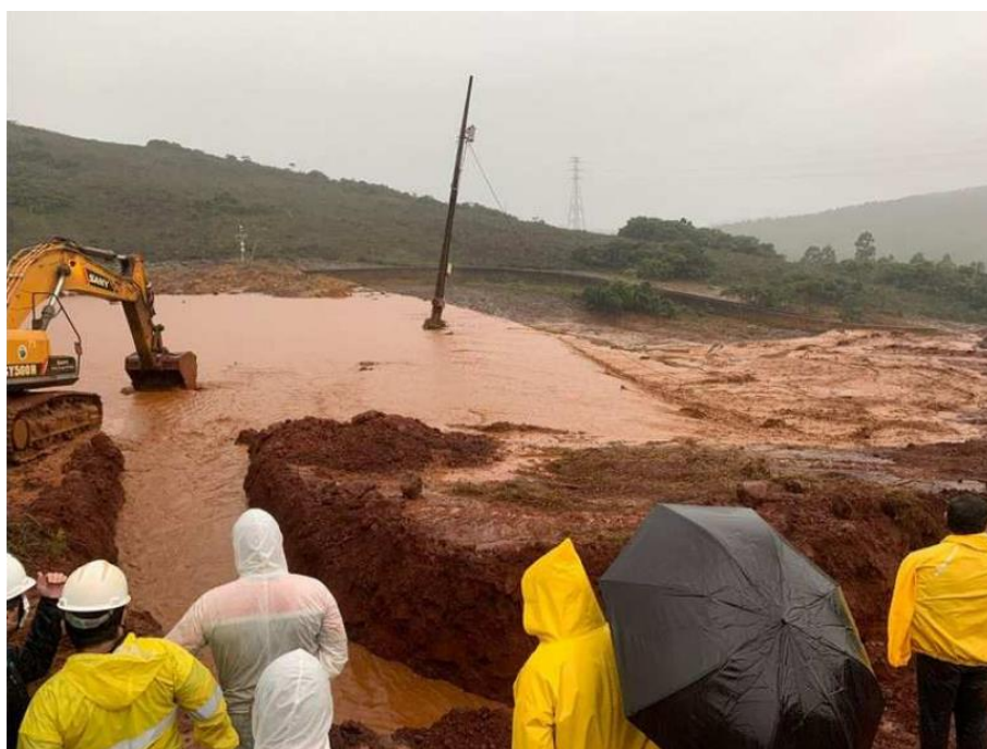
Figura 8: Dique Lisa sendo galgado e escavação do extravasor de emergência na ombreira direita.
