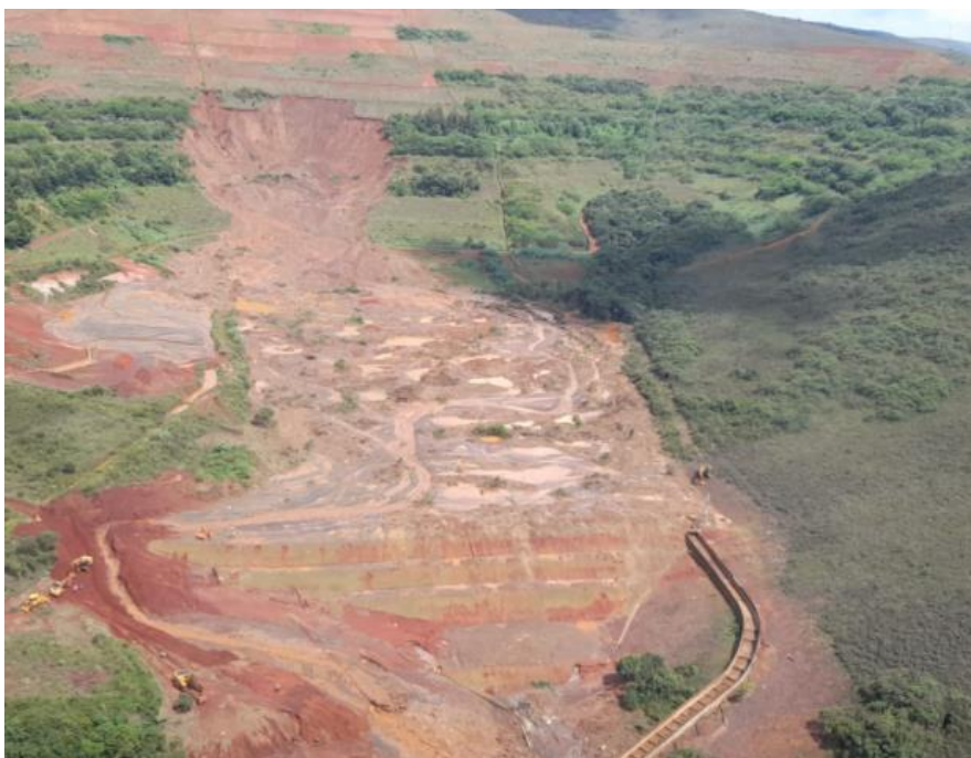
Figura 11: Vistoria aérea do Dique Lisa com destaque para a Pilha Cachoeirinha rompida à montante da estrutura.
