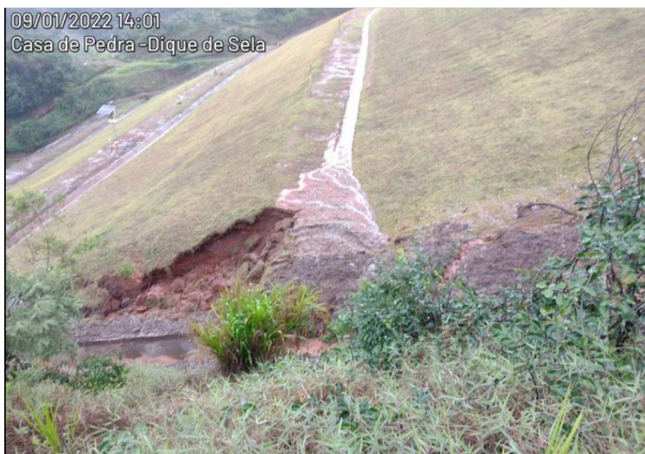
Figura 12: Dique de Sela da barragem Casa de Pedra com erosão causada por falha na drenagem superficial.
