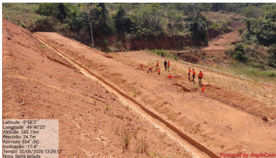
Figura 2: Canaletas de drenagem superficial limpas após a ação.
