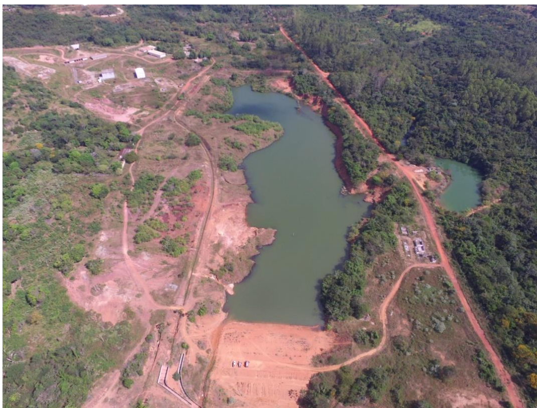
Figura 1: Vista geral da barragem e reservatório
