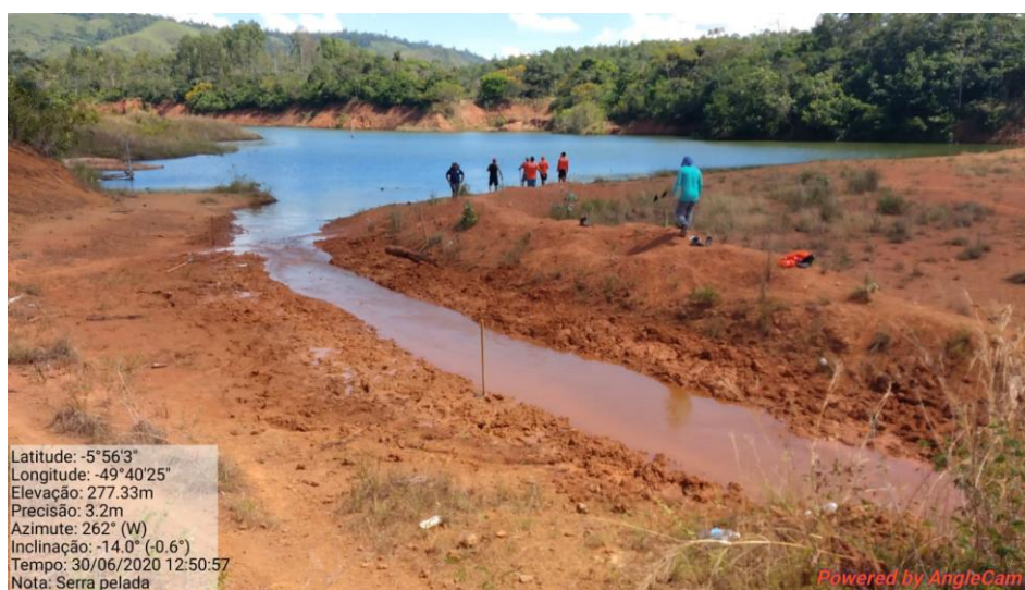
Figura 4: Extravaseiro de emergência após a limpeza pelas equipes da ANM e Defesa Civil.
