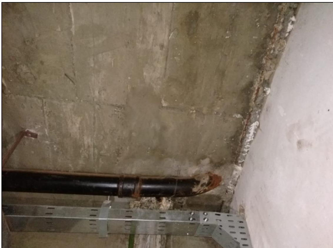
Foto 6 – Tubulação com oxidação. Nesse local a parede está muito úmida, indicando que há rompimento do tubo.
