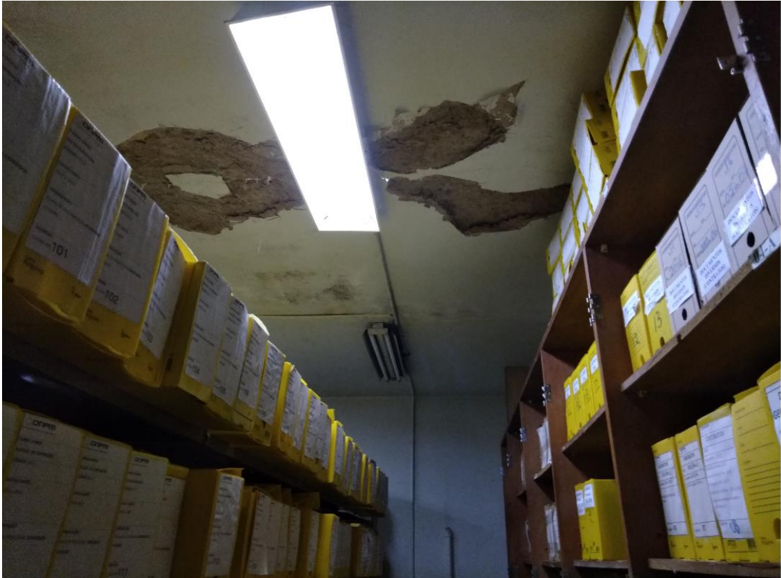
Foto 8 – Desprendimento de parte do material da laje decorrente do processo de infiltração.
