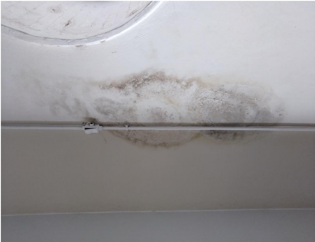
Foto 1 – Infiltração da laje do subsolo
