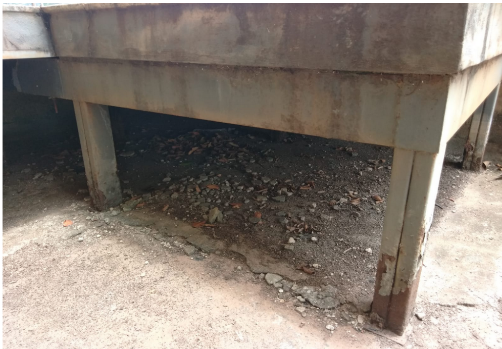
Figura 4 - Vista da estrutura metálica de sustentação da passarela de entrada do edifício da ANM/DF
