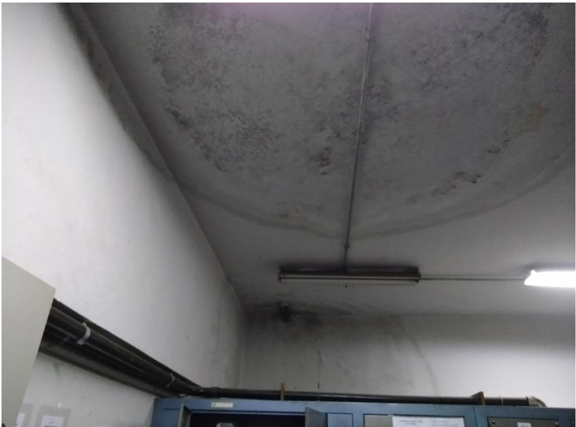
Foto 4 – Infiltração em cima da subestação de energia (grande perigo de curto-circuito)
