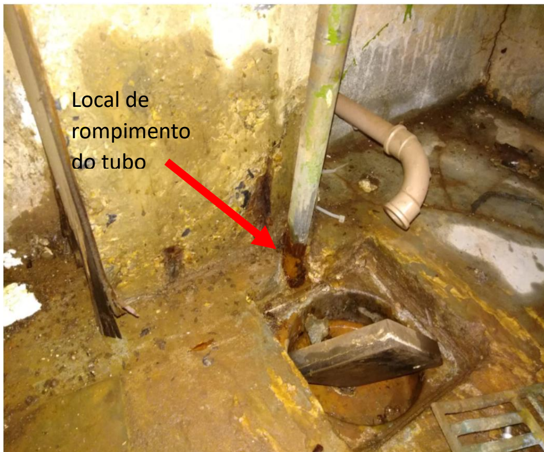
Foto 1 – Local de rompimento da tubulação metálica. É possível verificar que o ponto de rompimento está oxidado. Essa condição está presente em locais da edificação.
