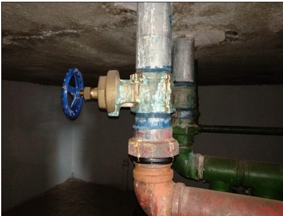
Foto 3 – Tubulações que saem da caixa d'água superior. É possível observar que esses tubos apresentam desgaste e falta de manutenção.
