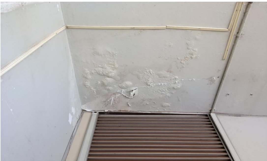
Foto 2 – Infiltração e lixiviação do concreto (Subsolo)
