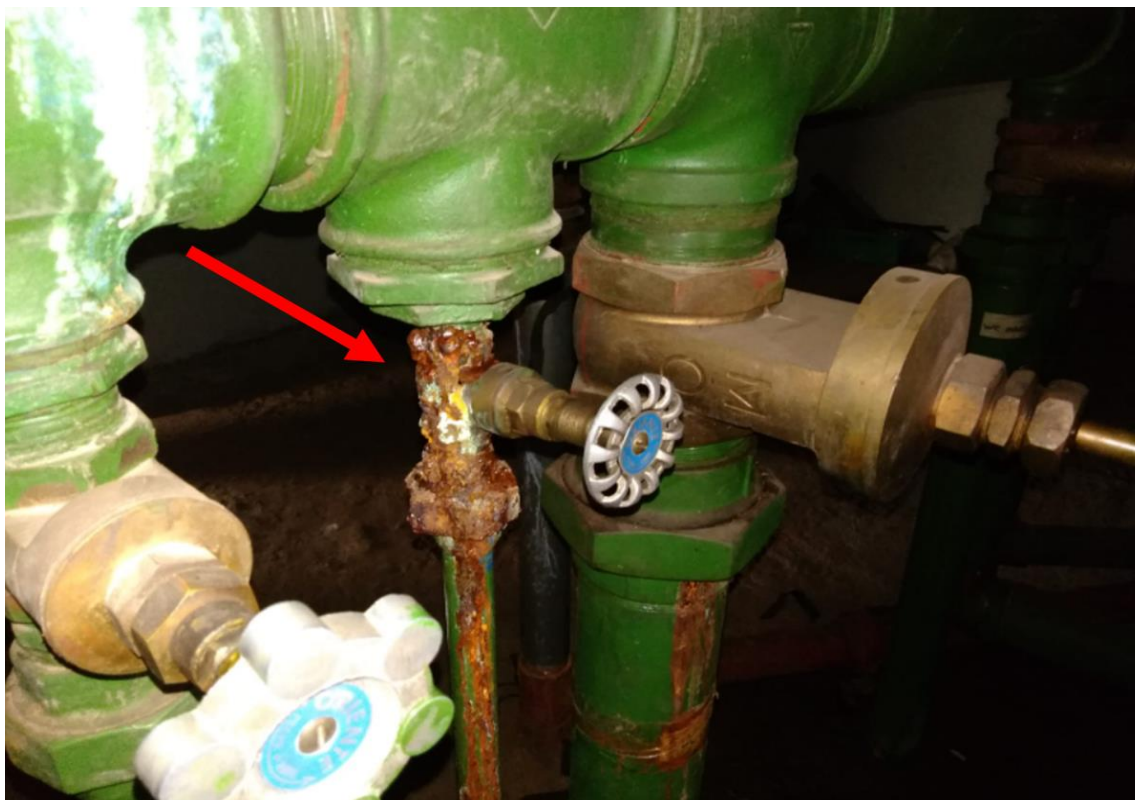
Foto 2 – Tubulação metálica comprometida pela oxidação. Essa tubulação está conectada ao ramal que vem da caixa d'água superior. O registro de gaveta também está comprometido.
