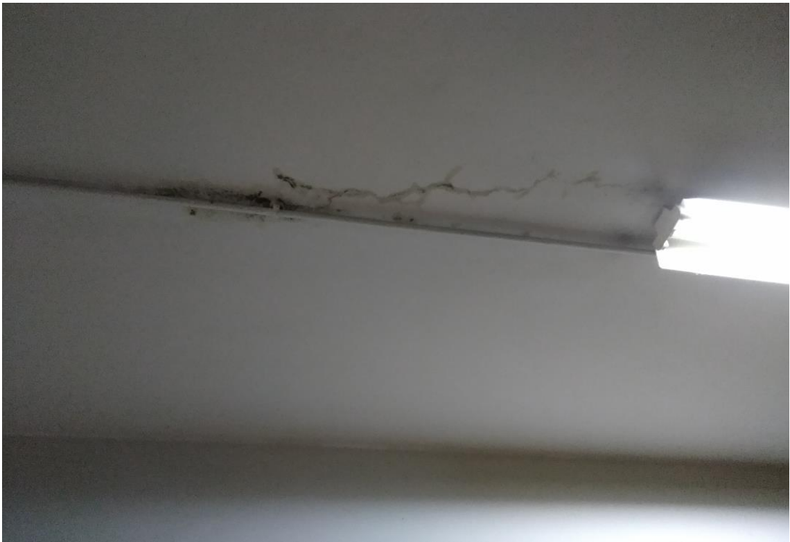
Foto 3 – Trincas na laje decorrentes da infiltração (subsolo)
