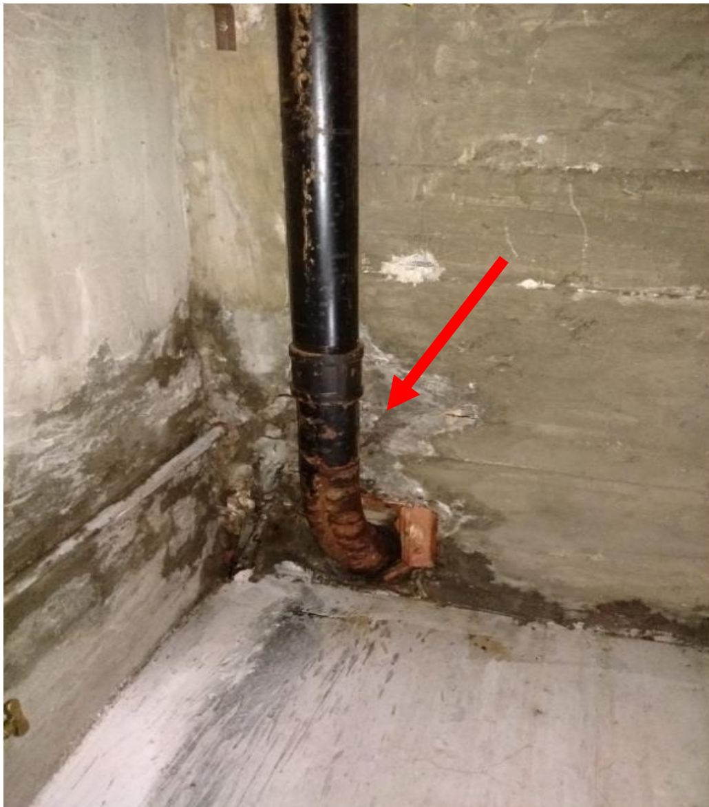
Foto 5 – Curva metálica com oxidação. Outro possível local de rompimento.
