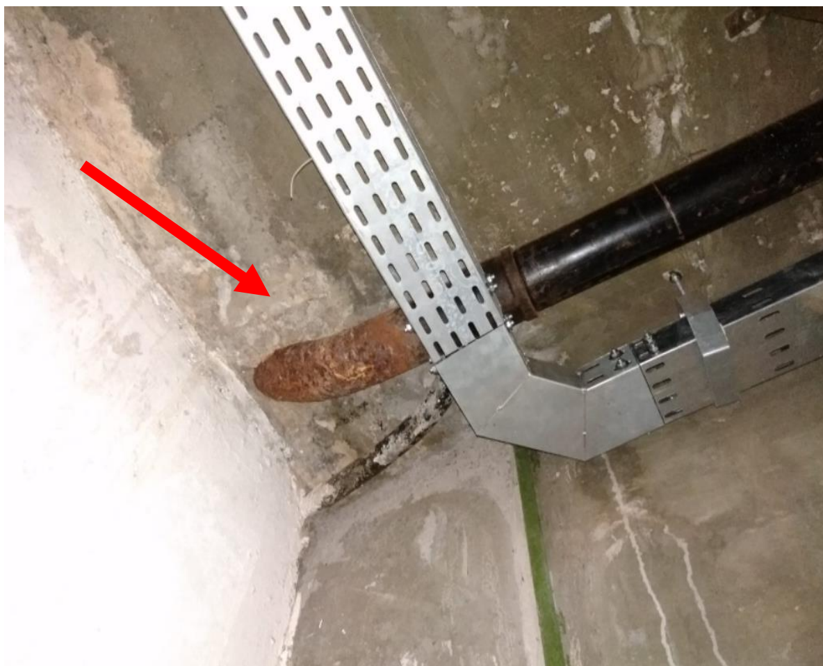
Foto 4 – Estado de oxidação avançada em um ramal de tubulação metálica. Local de possível rompimento.
