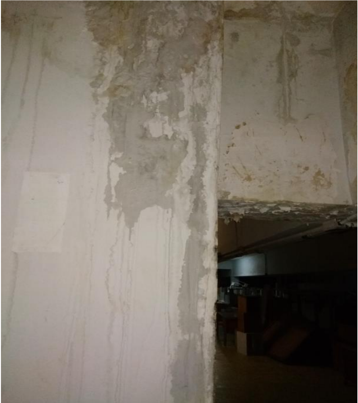
Foto 7 – Água escorrendo pelo pilar (água decorrente de infiltração)
