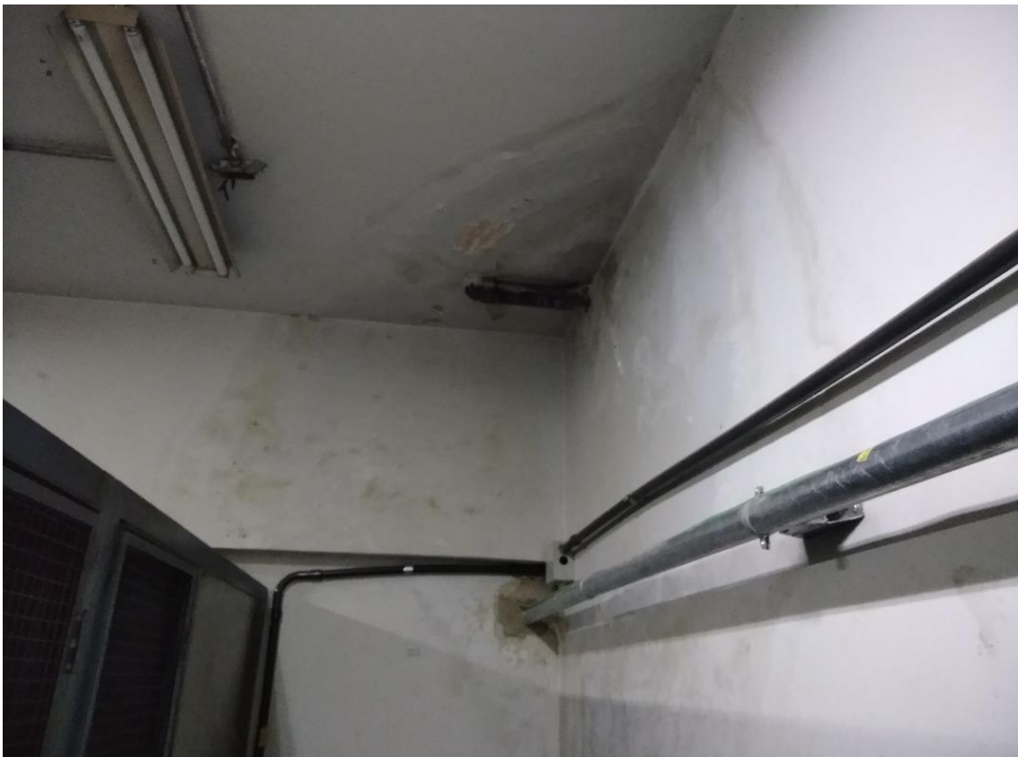
Foto 5 – Infiltração na parede onde está situada a subestação de energia
