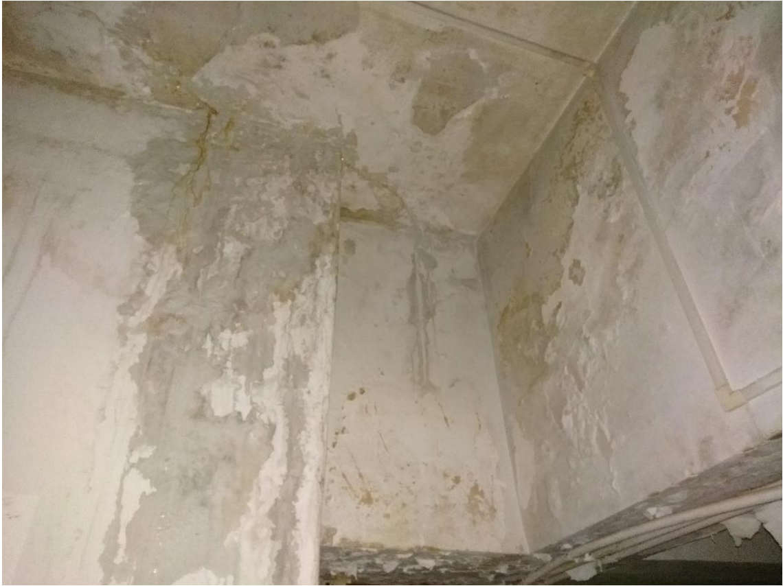
Foto 6 – Infiltração em um dos pilares e viga de sustentação (Subsolo)
