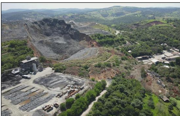
Figura 5 – Ruptura do talude da PDER Satinoco em 2024
