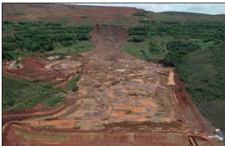
Figura 4 – Ruptura do talude da PDER Cachoeirinha em 2022
