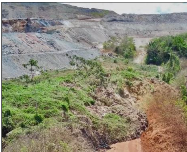
Figura 3 – Ruptura do talude da Pilha de Estéril Norte em 2023
