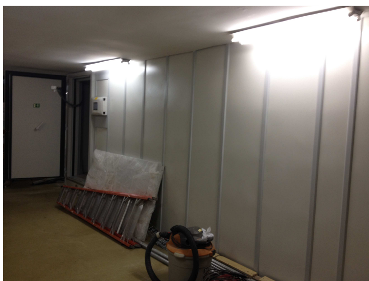
Figura 12: Nova Sala-Cofre – Visão Externa
