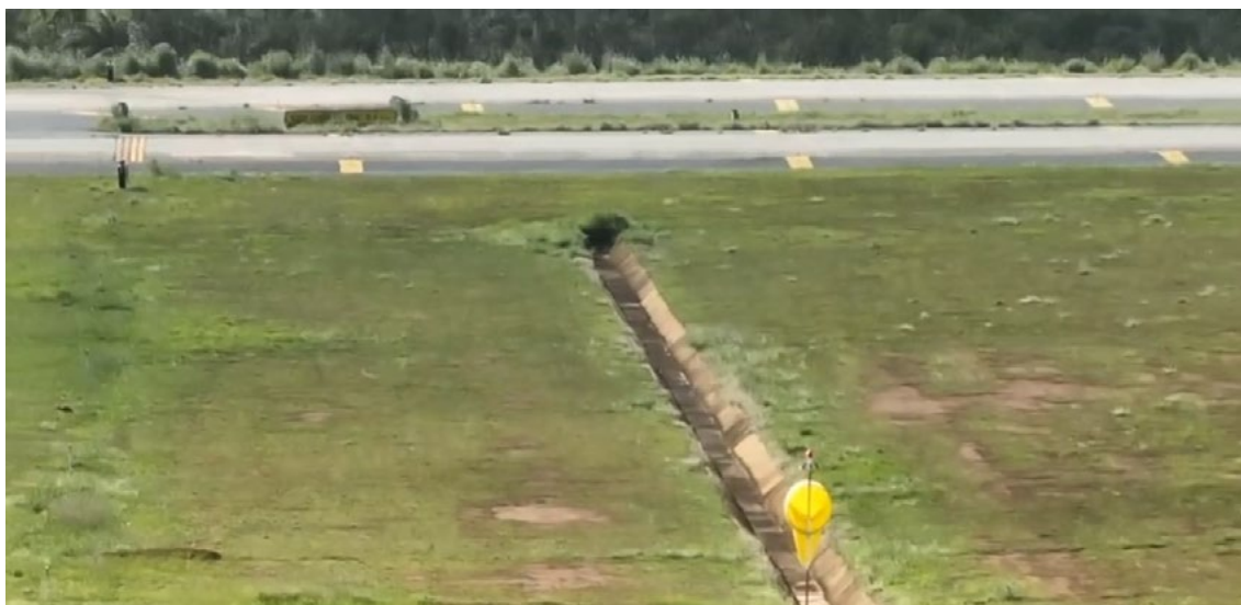
Figura 112. Inspeção de vala de drenagem do Airport (SBCF).
