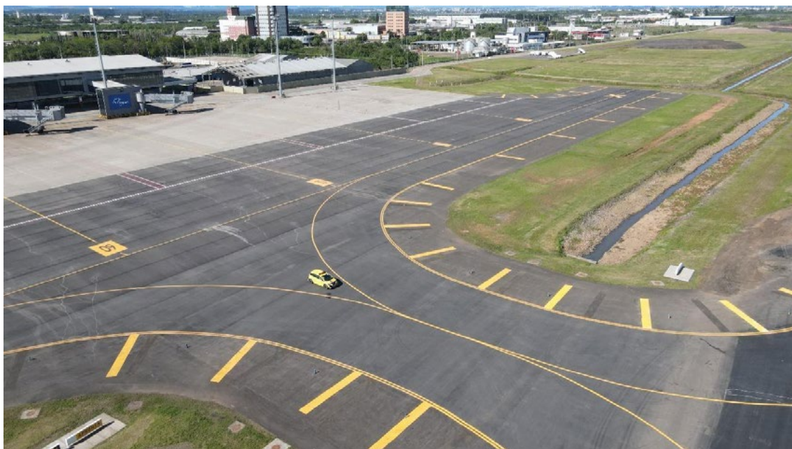
Figura 20. Inspeção de sinalização horizontal no pátio de aeronaves do Porto Alegre Airport (SBPA).
