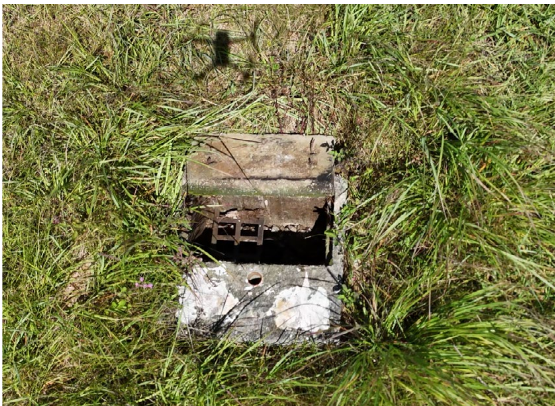
Figura 56. Zoom capturado pelo drone registrando que a caixa de passagem estava com a tampa aberta - Zurich Airport Brasil (SBFL).
