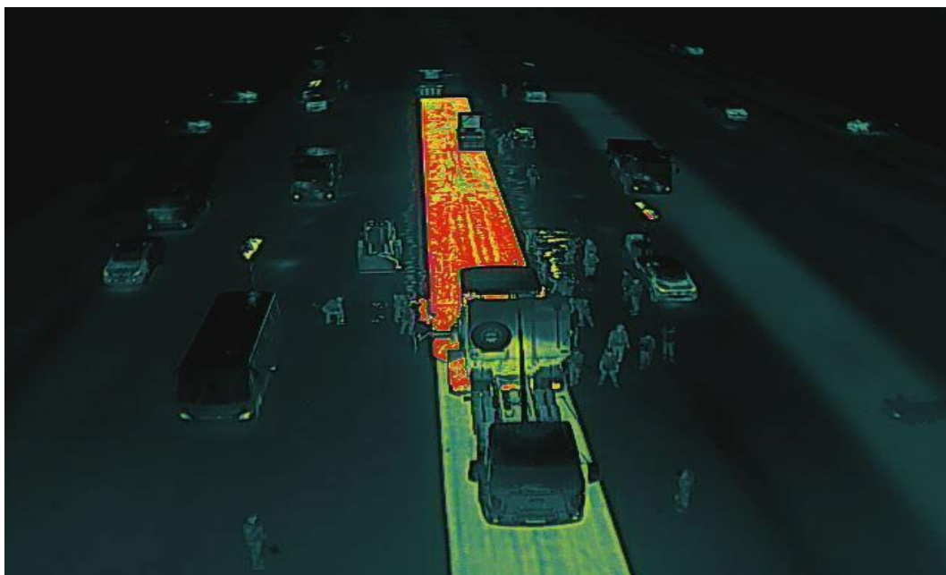
Figura 39. Acompanhamento de recape na pista de pousos e decolagens do Porto Alegre Airport (SBPA) com uso de câmera térmica.
