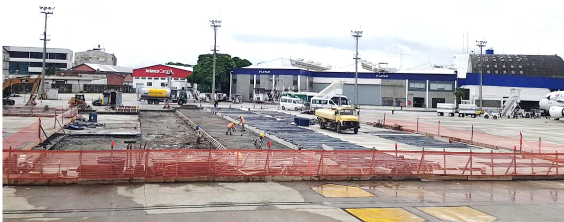
Figura 22: Isolamento de obra em áreas do estacionamento do Aeroporto de São Paulo - Congonhas. Veem-se as barreiras de contenção de FOD, como as tábuas junto ao piso e as telas mais acima.
