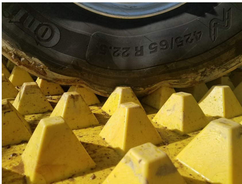
Figura 53: Detalhe da faixa de vibração e do pneu deformado para que os detritos da obra não se espalhem pela área de movimento.
