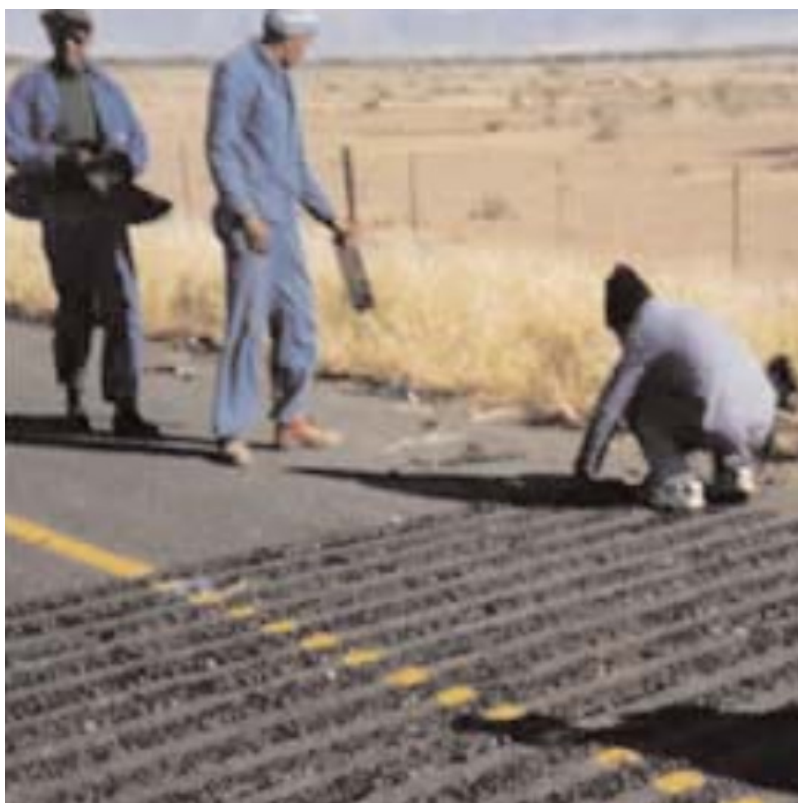
Figura 54: Faixas de vibração de material asfáltico permanentes instaladas na via de serviço com acesso à área de movimento.
