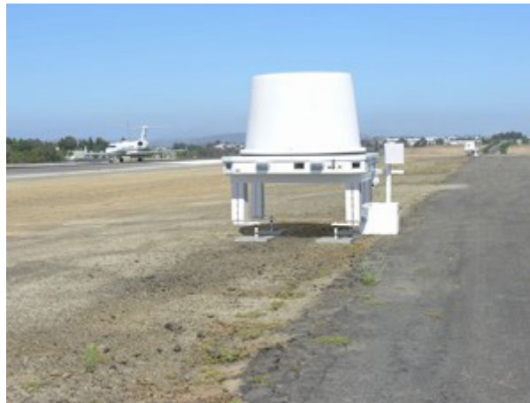
Figura 36: FOD Finder em uma instalação estática ao lado de uma pista. Verifique outro equipamento mais à frente, junto à pista ( FOD Finder , 2021).
