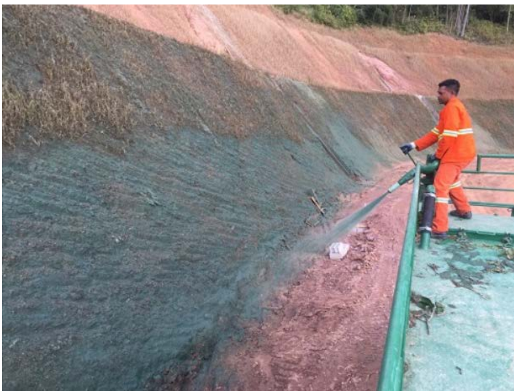
Figura 25 – Hidrossemeadura em talude.
