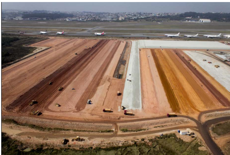
Figura 31 – Terraplanagem para construção do Terminal de Passageiros 3 do Aeroporto Internacional de Guarulhos/SP.
