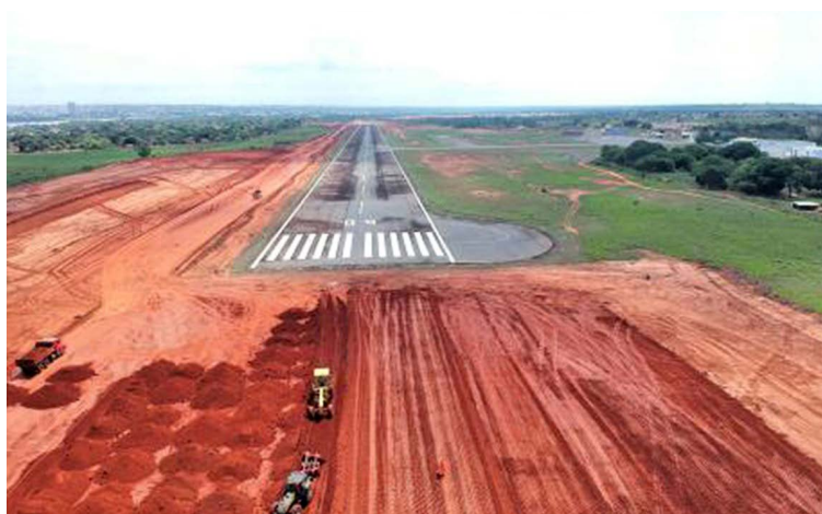
Figura 30 – Terraplanagem para construção de RESA no aeroporto de Araguaína/TO.
