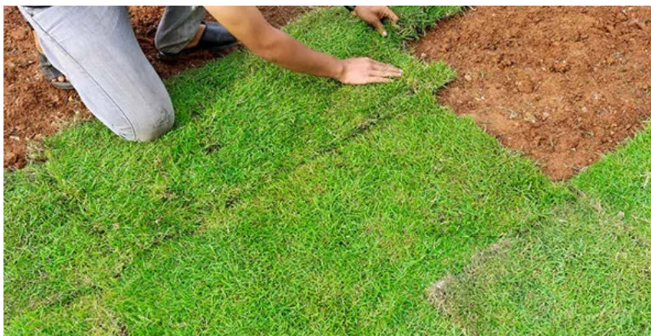
Figura 27 – Plantio de grama por meio de placas.
