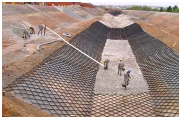
Figura 32 – Canal de macrodrenagem com geocélula e geotêxtil no Aeroporto Internacional de Guarulhos/SP.
