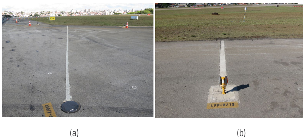
Figura 12 – Cortes no pavimento para passagem de cabos do sistema elétrico para acionamento da sinalização luminosa.
