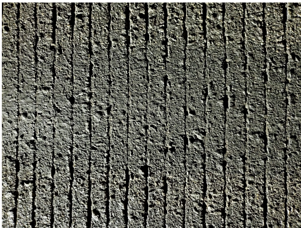
Figura 25 – Obstrução do grooving em superfícies asfálticas aeroportuárias.
