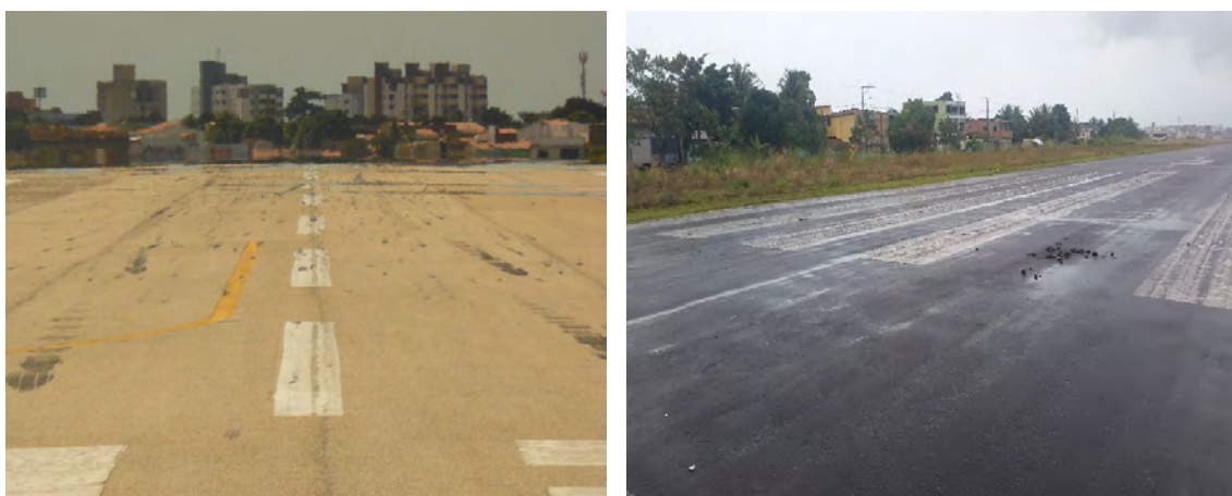
Edificações violando as superfícies definidas no Plano Básico de Zona de Proteção de Aeródromo (Fonte: Arquivo ANAC)
