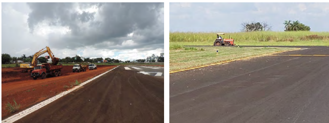
Exemplos de Obras e Serviços de Manutenção realizados no aeródromo (Fonte: Arquivo ANAC)
