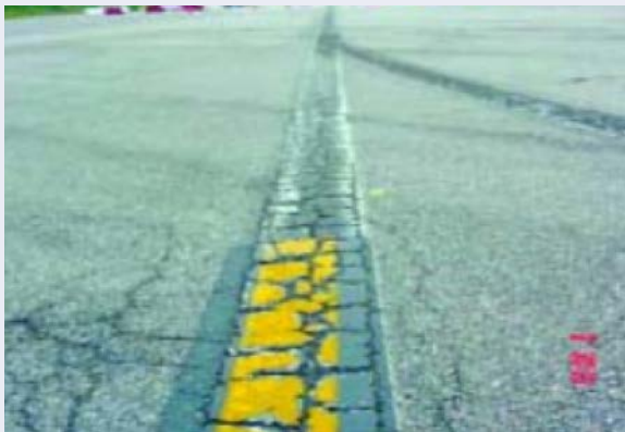
Foto retirada do relatório de investigação do acidente: Sinalização horizontal de eixo de táxi.
