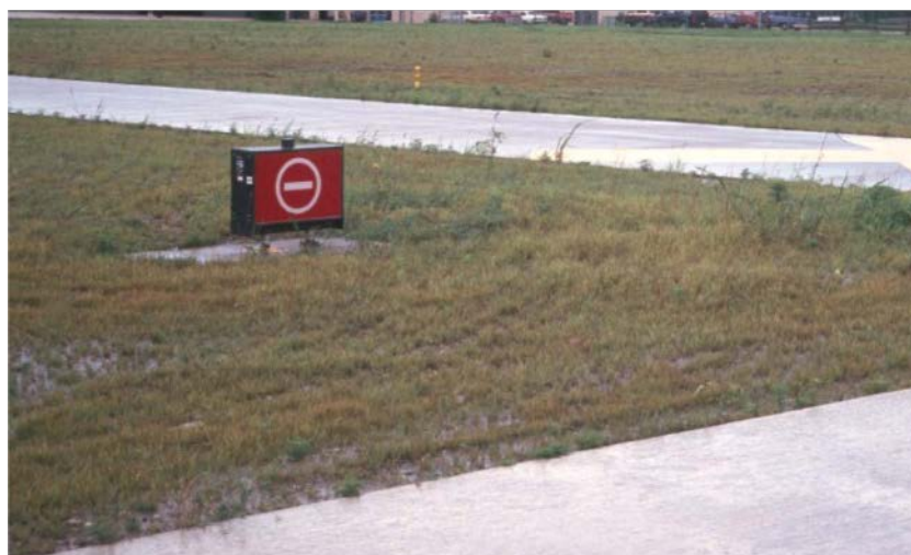
Figura A.15 Sinalização vertical de instrução obrigatória do tipo "NO ENTRY" (NÃO ENTRE)
