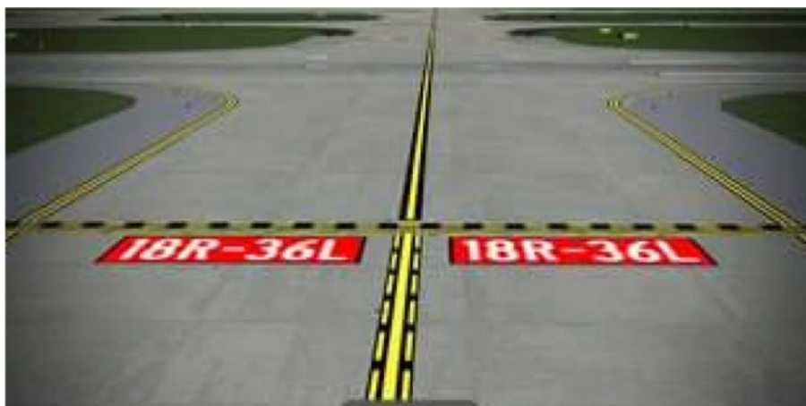
Figura A.11 Sinalização horizontal de instrução obrigatória
