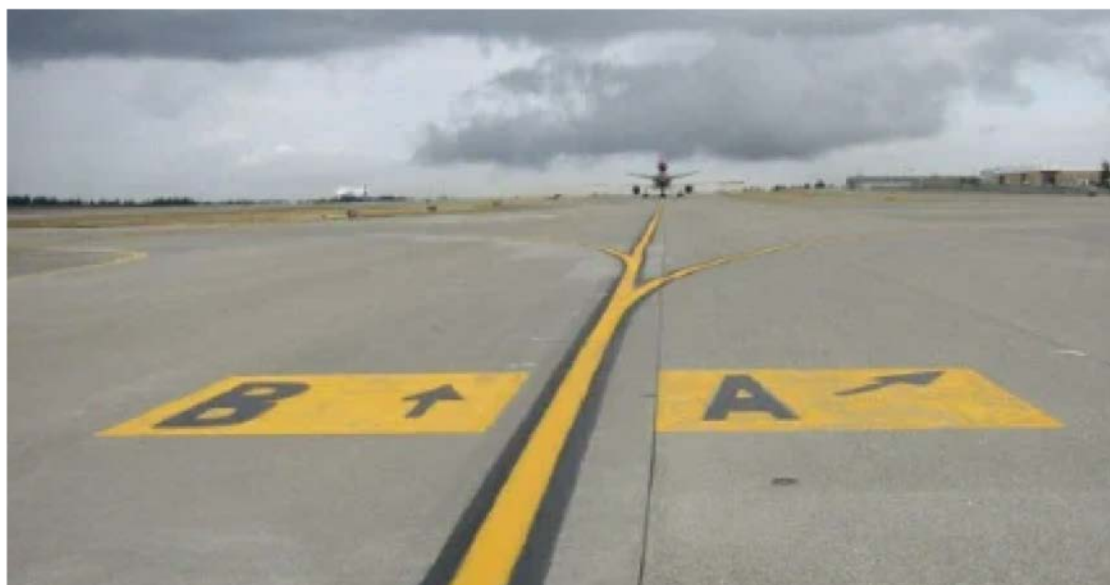
Figura A.13 Sinalização horizontal de informação (Fonte Flight Literacy https://aviatorsguide.wordpress.com/2020/06/15/airport-markings/ )
