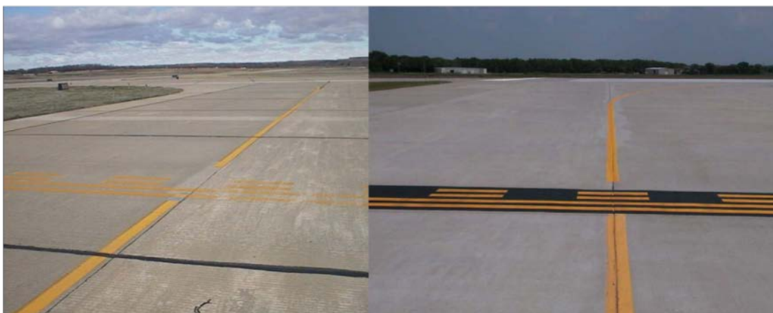
Figura A.14 Conspicuidade – comparação de dois tipos iguais de sinalização com e sem grau de contraste (Fonte FAA, Holding Position Markings and Mandatory Instruction Signs)
