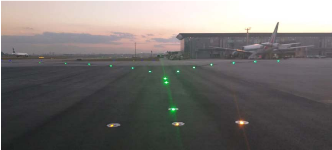
Figura A.18 Luzes de posição intermediária de espera
