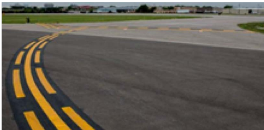
Figura A.10 Sinalização horizontal melhorada de eixo de pista de táxi
