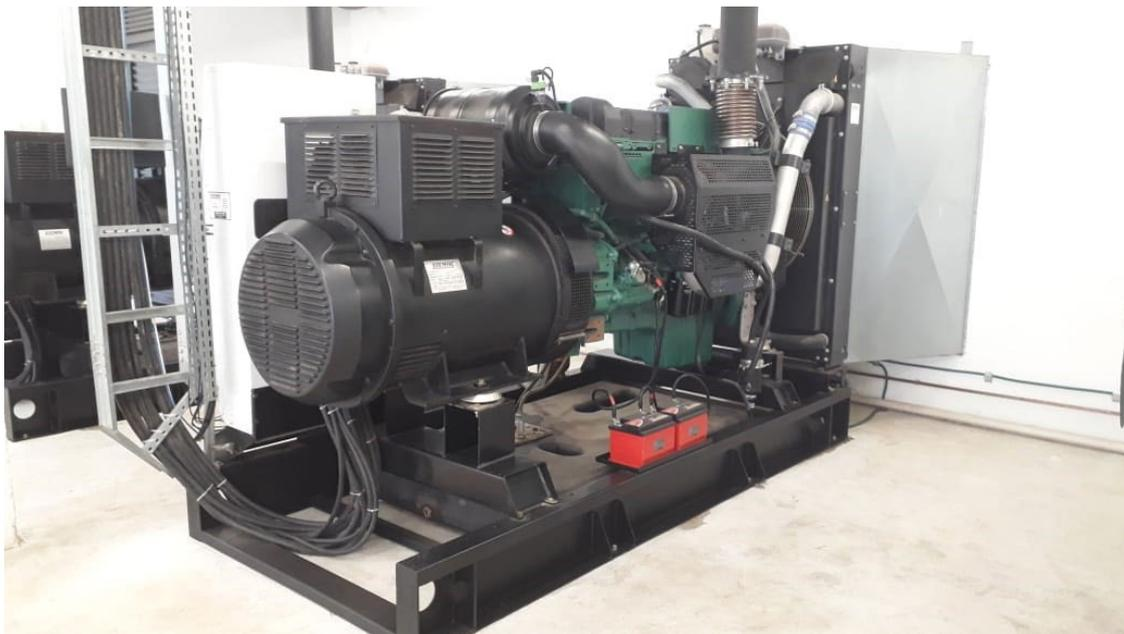
Figura 5 – Grupo motor gerador diesel-elétrico do Aeroporto Internacional de Curitiba/Afonso Pena (SBCT).
