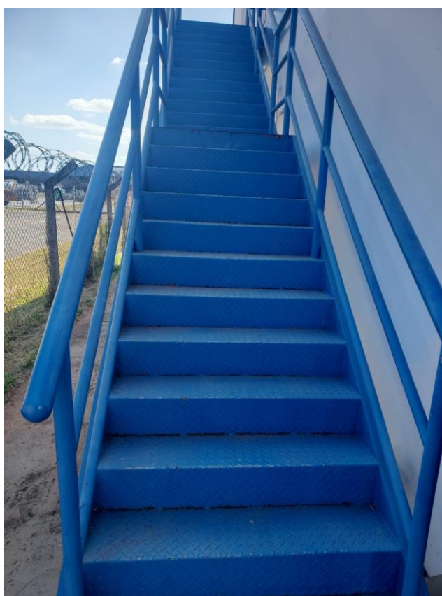
Figura 6 – Escada externa para saída de pavimento superior
