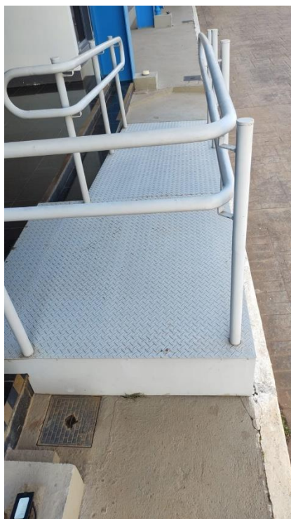
Figura 2 - Rampa de acesso ao auditório
