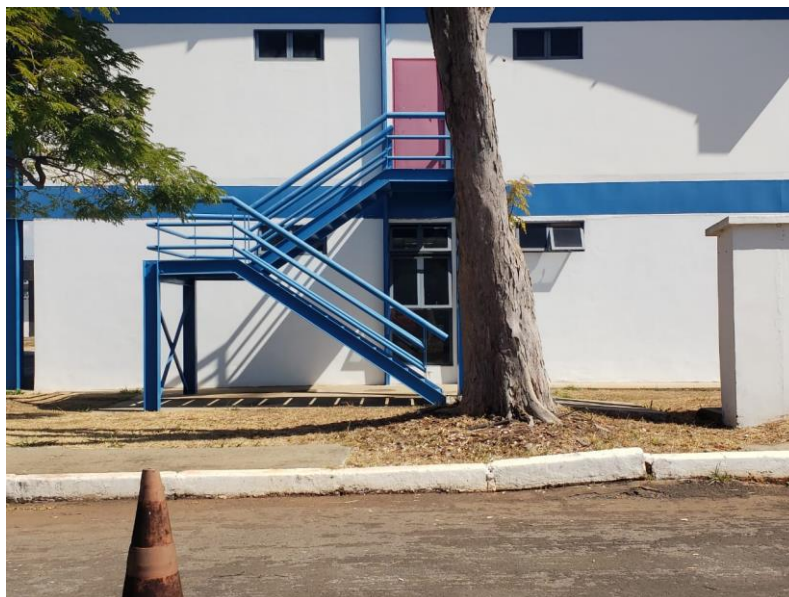
Figura 5 – Escada Externa para saída de pavimento superior
