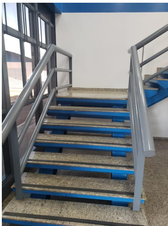
Figura 4 – Escada para Pavimento superior a Recepção
