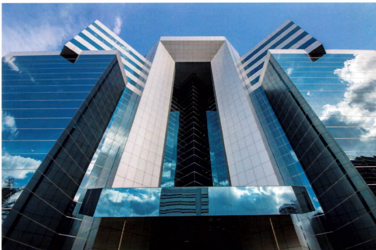
Fachada do Ed. Corporate Financial Center, que abriga o escritório da NOVA em Brasília.
