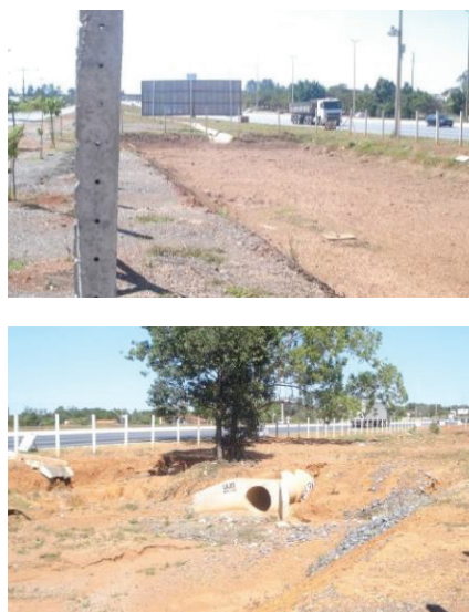
Figura 9 - Bacia de Detenção - DER. Fonte: SERENCO.
