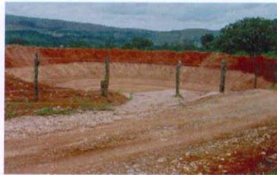
Foto 13 – Bacia de infiltração
