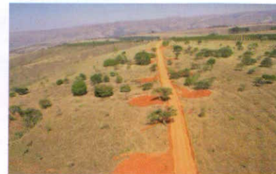
Foto 14 – Readequação de estradas
