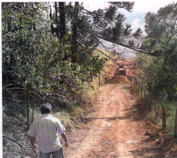
Foto 20 - Readequação de estradas.
