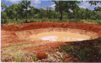
Foto 12 – Bacia de infiltração
