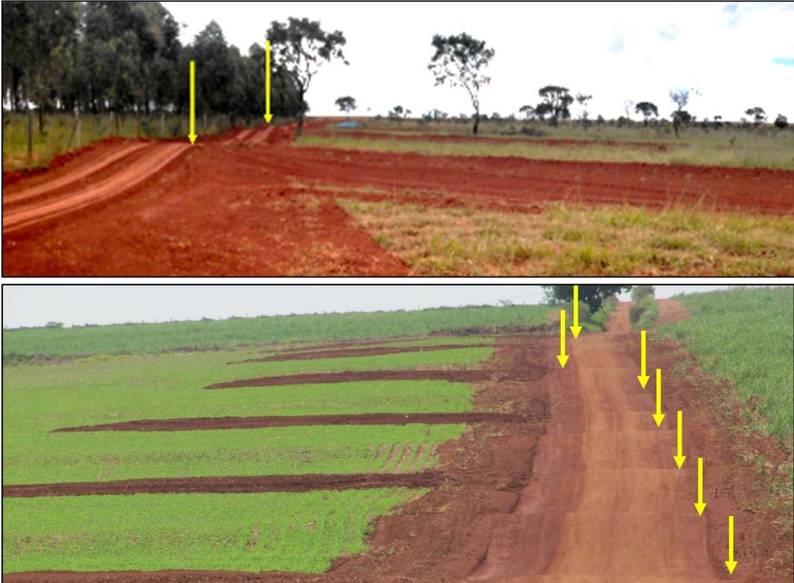
**Figura 7(a e b) - Indicação dos camalhões em estradas readequadas no âmbito do Programa Produtor de Água: projeto Pípiripau-DF (a) e projeto Nascentes em Botucatu-SP (b).**
