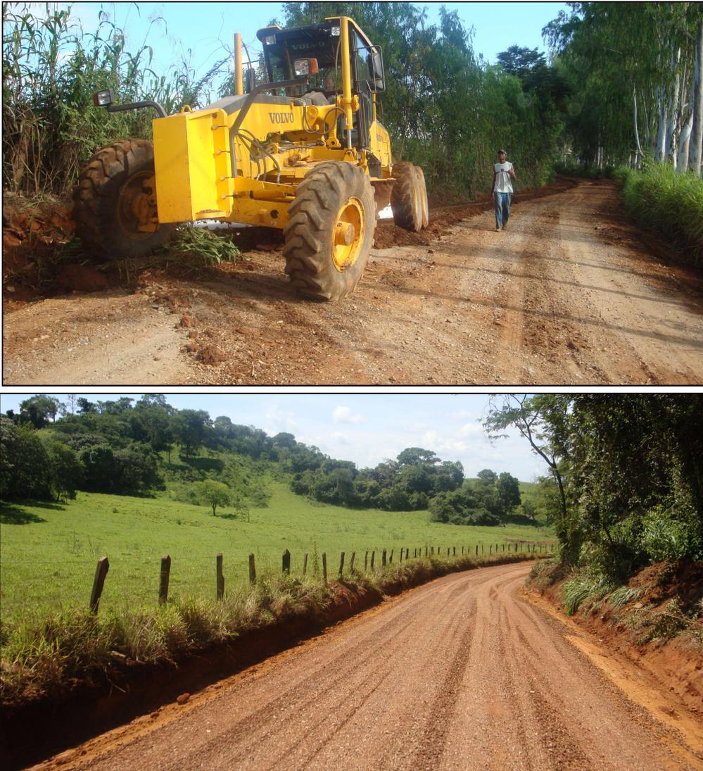
**Figura 5 (a e b) – Execução de sarjeta com motoniveladora (acima), com o serviço concluído (abaixo).**
