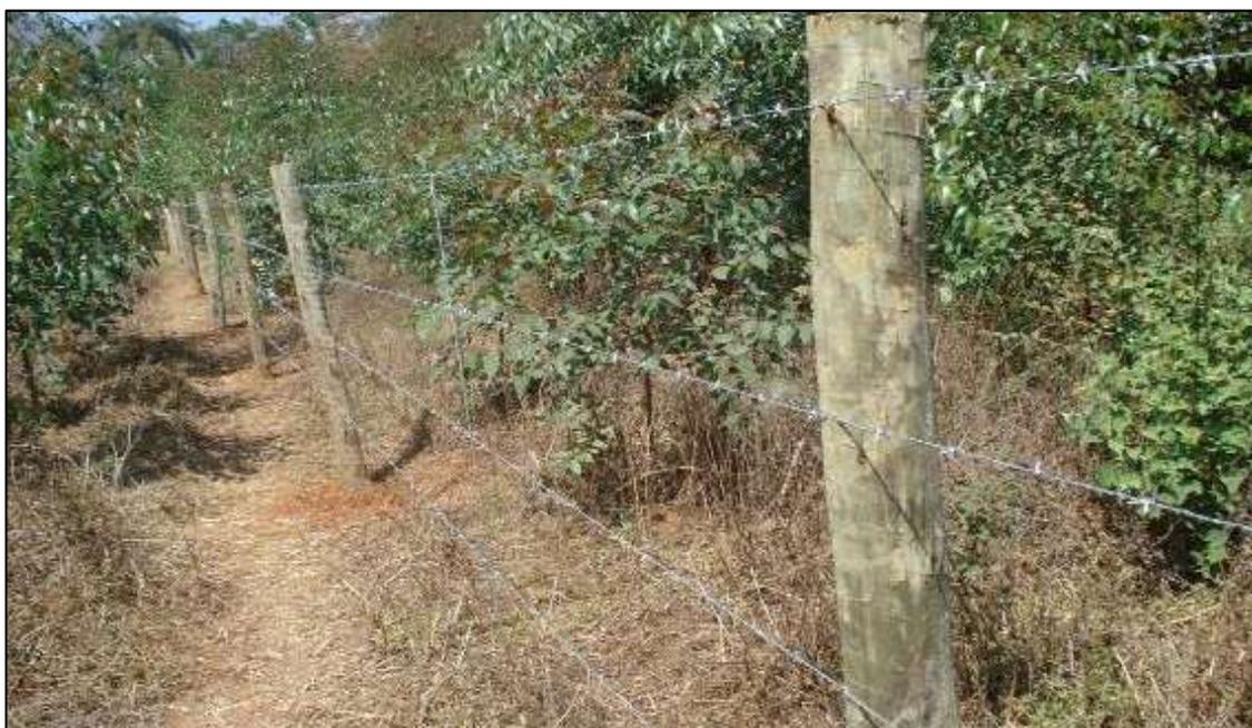
**Figura 22 – Cerca de eucalipto tratado (8 a 10 cm de diâmetro), arame farpado. Espaçamento de 4 metros entre mourões e 2 metros entre balancins.**
