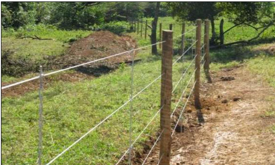
**Figura 23 – Cerca de eucalipto tratado (8 a 10 cm de diâmetro), arame liso. Espaçamento de 4,5 metros entre mourões e 1,5 metro entre balancins.**
