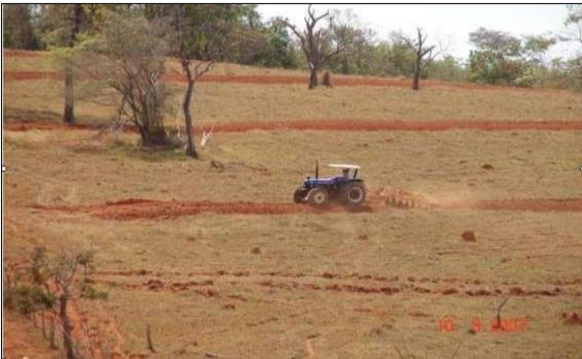
**Figura 15 (a e b) - Construção de terraço de base larga com arado terraceador realizada em projeto do Programa Produtor de Água em Minas Gerais.**
