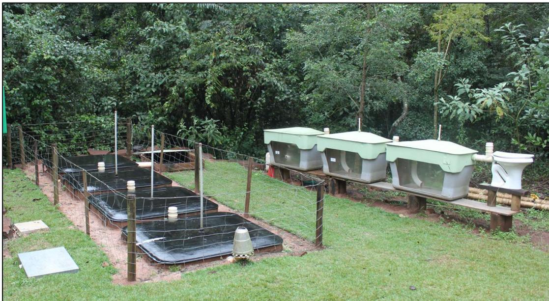
**Figura 25 – Ilustração fotográfica de fossa séptica de 3 módulos desenvolvida pela EMBRAPA.**
