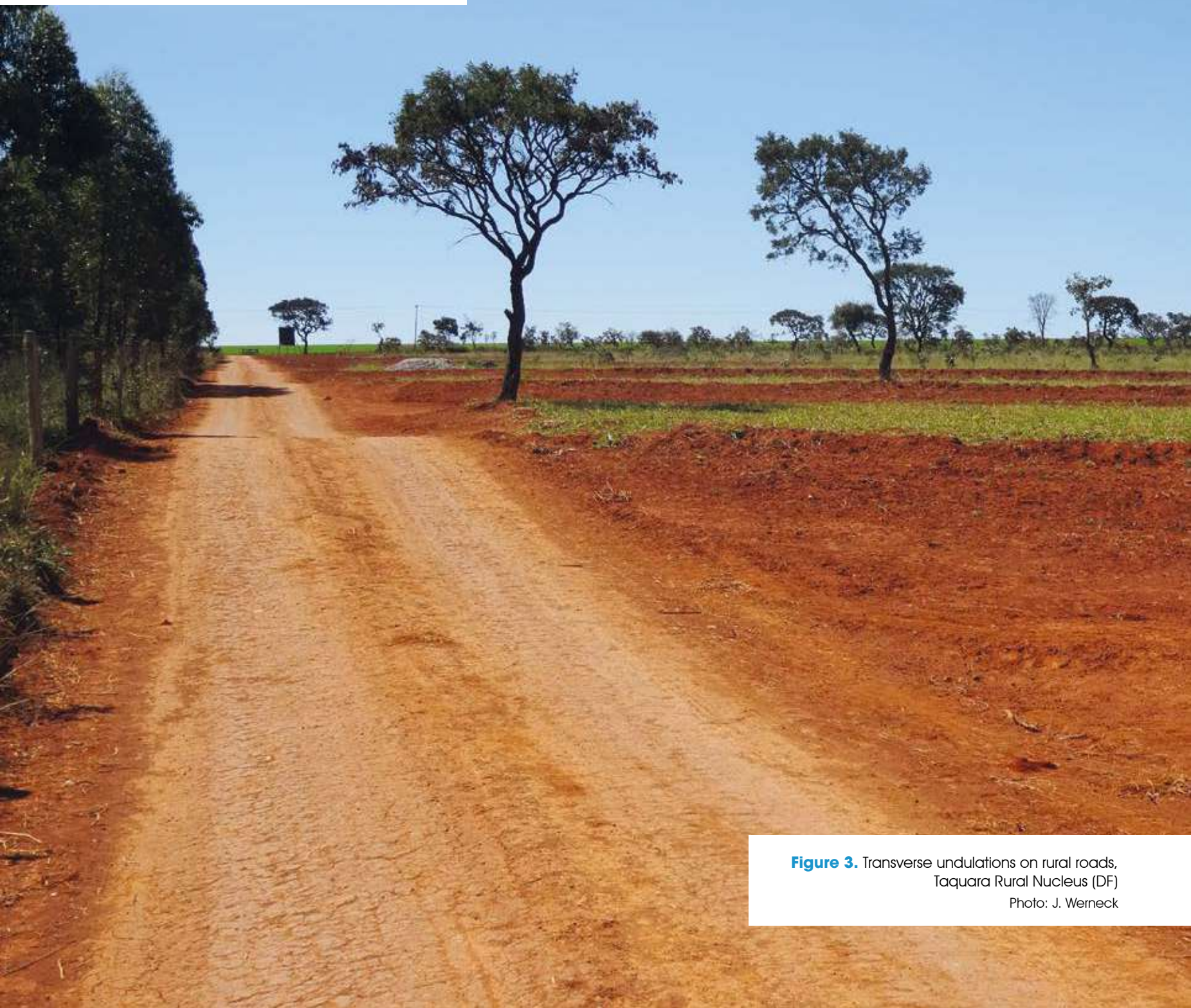
Figura 3. Ondulação transversal em estradas rurais, Núcleo Rural Taquara (DF) Foto: J. Werneck
