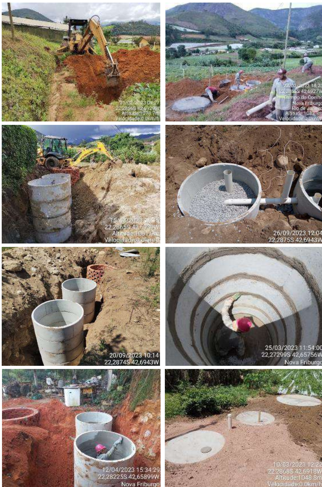
Figura 22. Obras de instalação de sistemas de tratamento de efluentes domésticos na microbacia de Barracão dos Mendes em Nova Friburgo/RJ.
