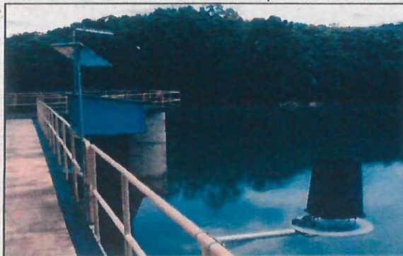
Figura 4 - Represa Cachoeira - sensor nível com transmissão por telemetria em intervalos de 10 minutos
