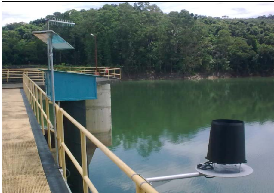
Figura 22 – Estação telemétrica Barragem Cachoeira
