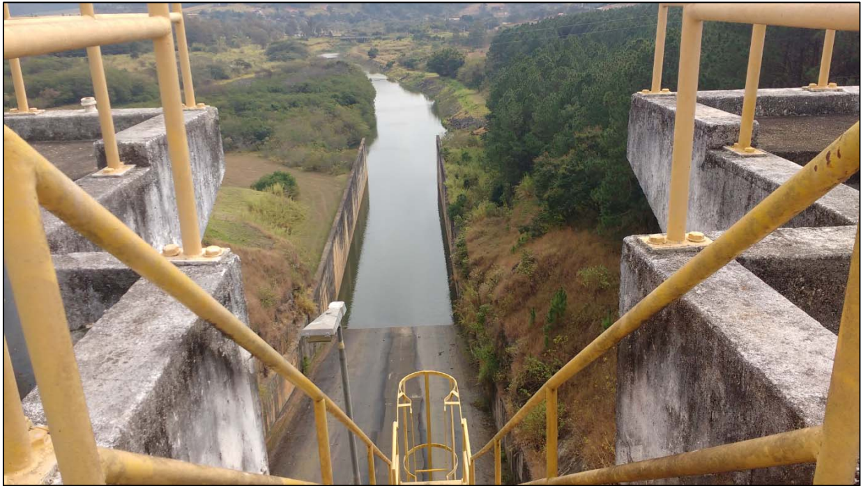
Figura 13 - Descarregador de superfície da Barragem Jaguari
