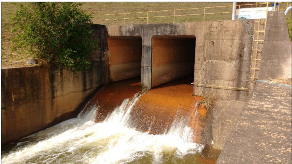
Figura 12 – Descarregador de fundo da Barragem Jaguari
