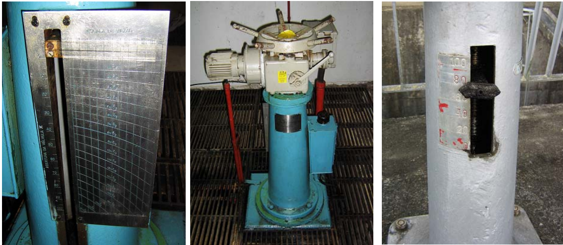
Figura 7 – Válvula de abertura e escala com porcentagem de vazões.
