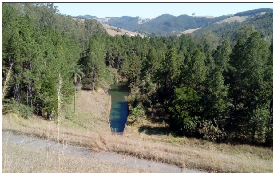
Figura 20 – Jusante Barragem Cachoeira
