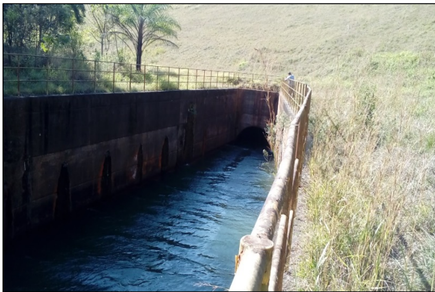
Figura 19 – Descarregador da Barragem Cachoeira
