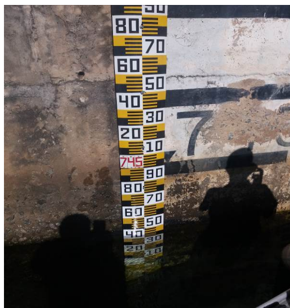
Figura 33 – Régua linimétrica Barragem Paiva Castro
