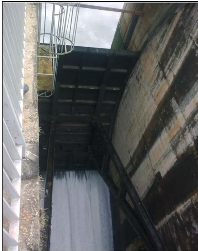
Figura 28 – Descarregador de superfície da Barragem Paiva Castro
