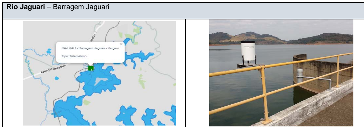
Figura 16 – Estação telemétrica instalada na Barragem Jaguari em Vargem/SP
