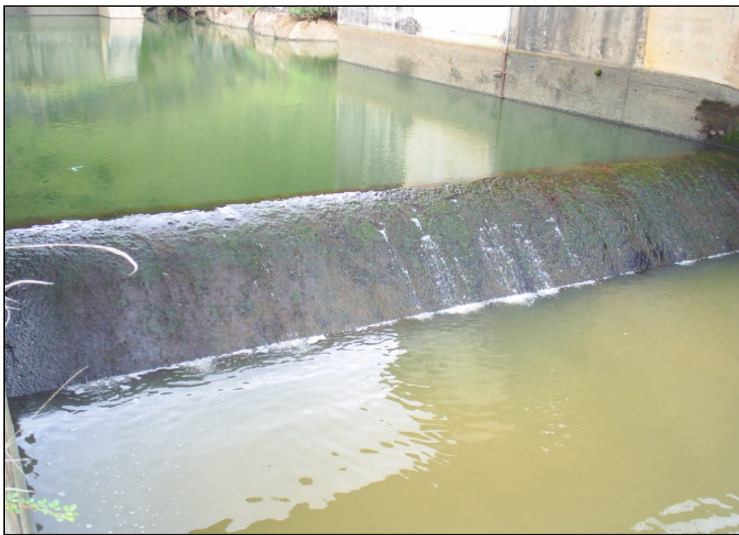
Figura 39 – Vertedor creager instalado no Desemboque do Túnel 5
