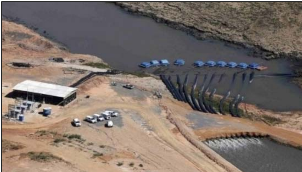
Figura 7 – Captação da reserva técnica na Represa Jacareí (emboque do túnel 7)
