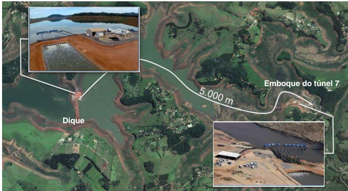
Figura 6 – Visão geral das elevatórias de captação da reserva técnica – barragem Jacareí.
