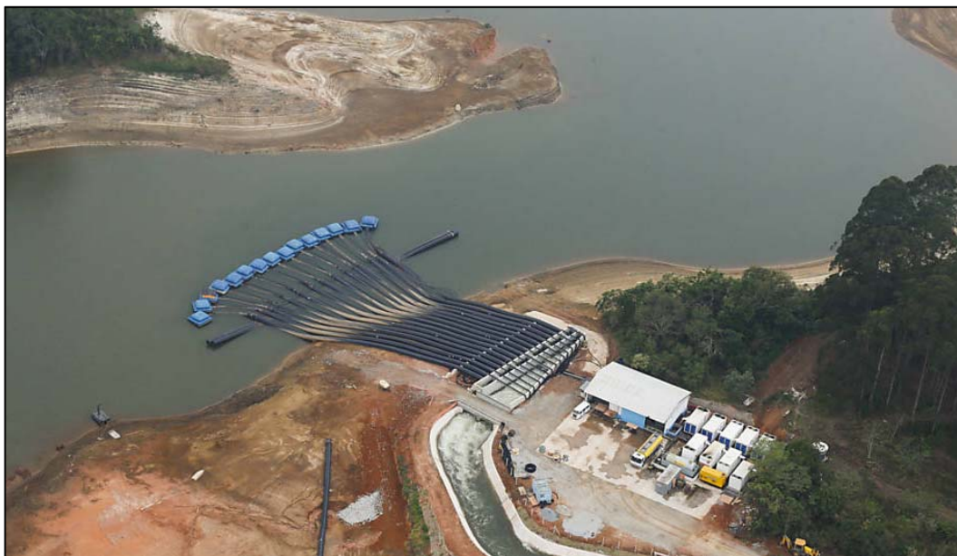
Figura 9 – Captação da reserva técnica na Represa Atibainha
