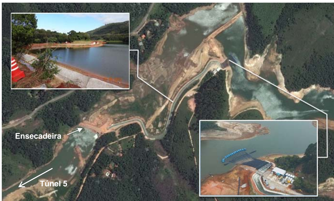
Figura 10 – Visão geral da elevatória de captação da reserva técnica – barragem Atibainha.
