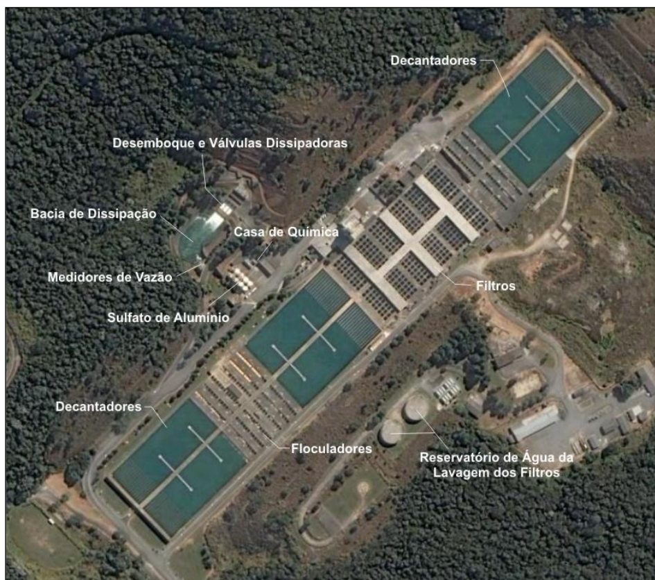
Vista da ETA Guaraú
