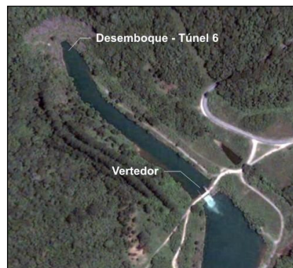
Desemboque do Túnel 6.
