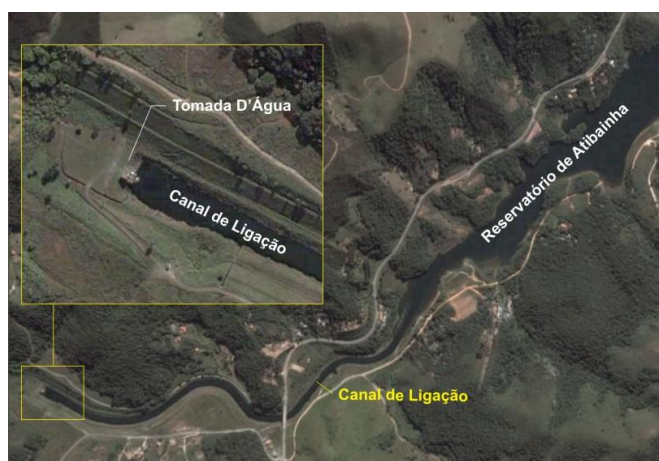
Emboque do Túnel 5.
