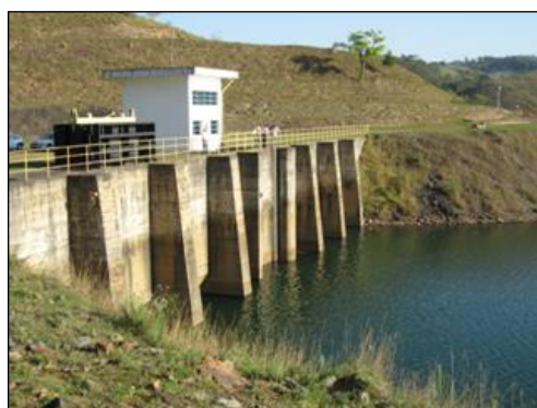
Emboque do túnel 6
