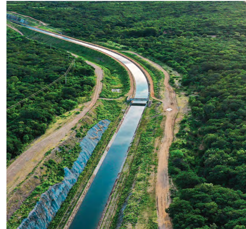
Segmento de canal - Eixo Leste Execução das obras de segmento de canal do Eixo Leste conduzidas pelo MIDR
