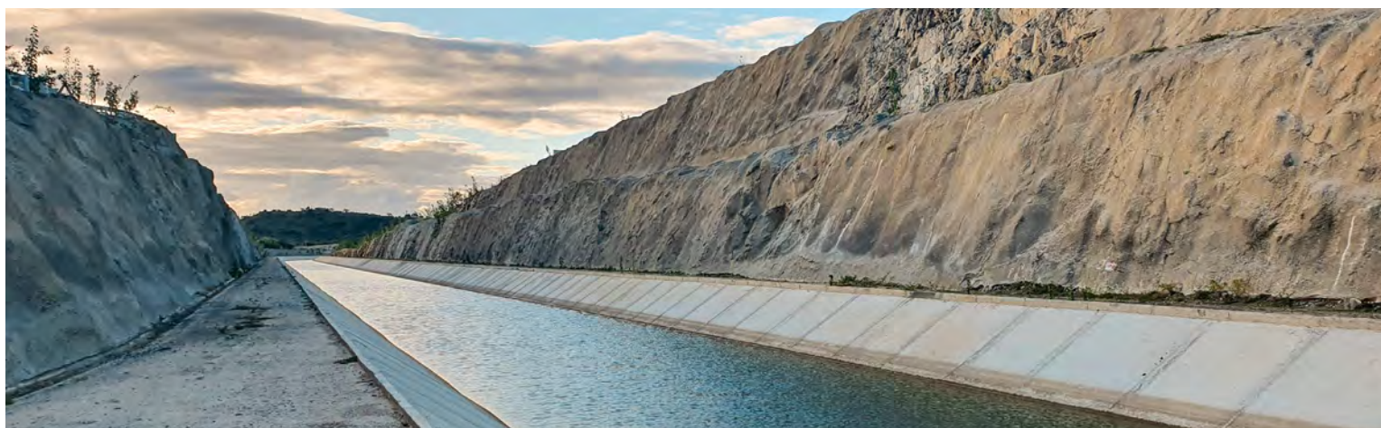
Trecho do canal do Ramal do Apodi Execução das obras em trecho de canal do Ramal do Apodi conduzidas pelo MIDR
