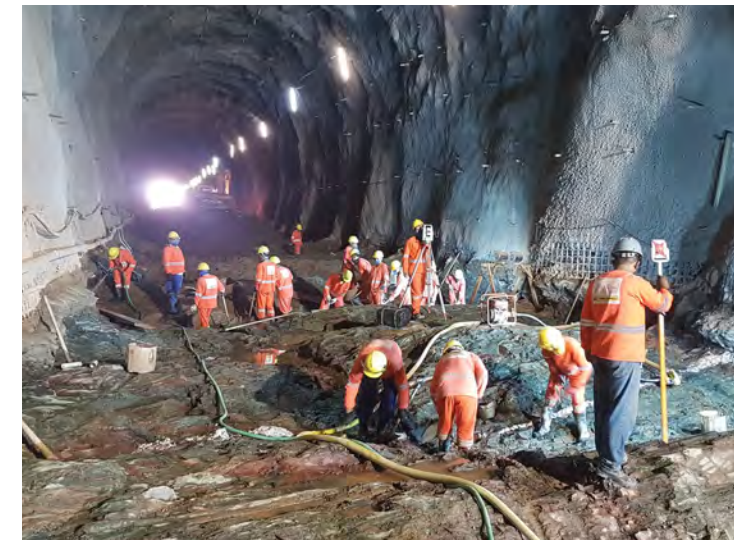
Túnel Cuncas 1 - Eixo Norte Foto: Bruno Rebouças / Banco de Imagens ANA
