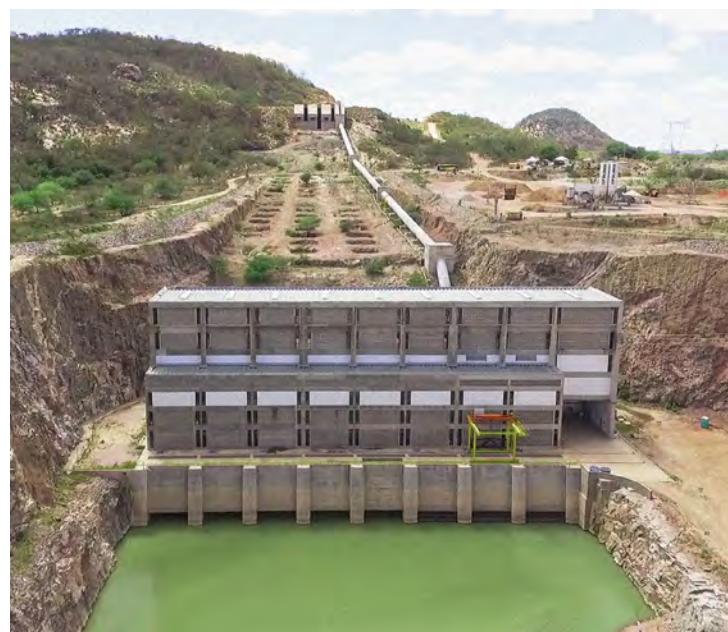
EBI-3 - Eixo Norte Execução das obras da Estação de Bombeamento EBI-3 no Eixo Norte conduzidas pelo MIDR
