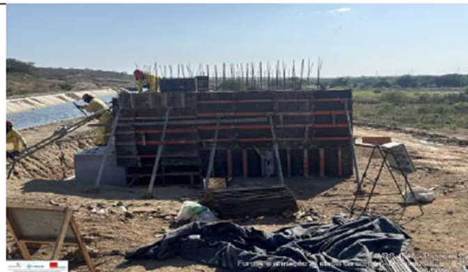
Foto 19: forma e armação das cortinas
