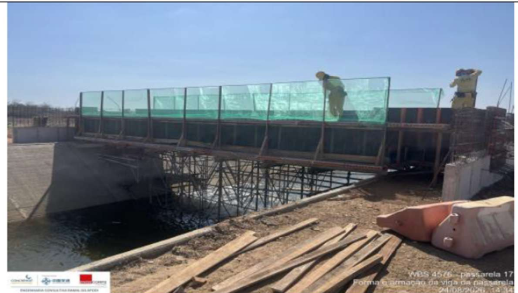
Foto 2: execução das formas e armação
