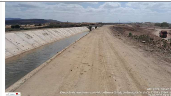
Foto 12: revestimento primário de berma
