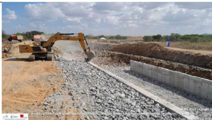
Foto 29: enrocamento nas paredes laterais – Overchute 01
