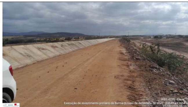
Foto 11: revestimento primário de berma
