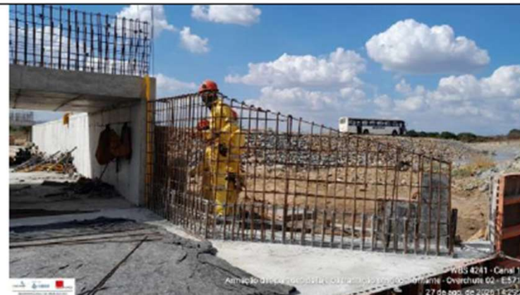
Foto 28: armação das paredes de transição – Overchute 02
