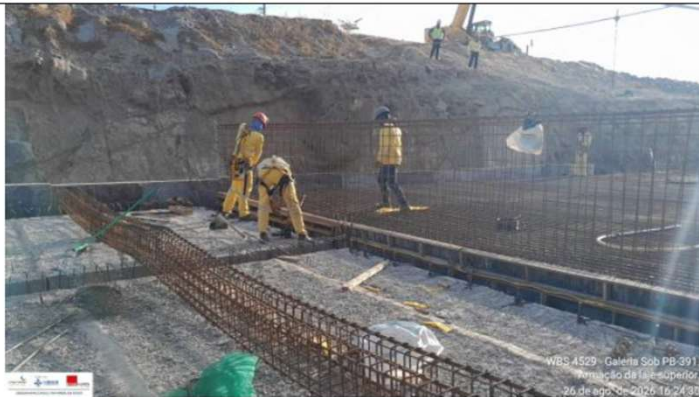
Foto 13: armação da laje superior
