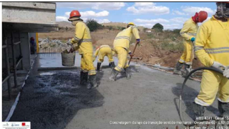
Foto 27: concretagem da laje de transição – Overchute 02
