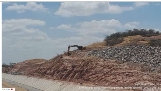
Foto 9: enrocamento do talude externo
