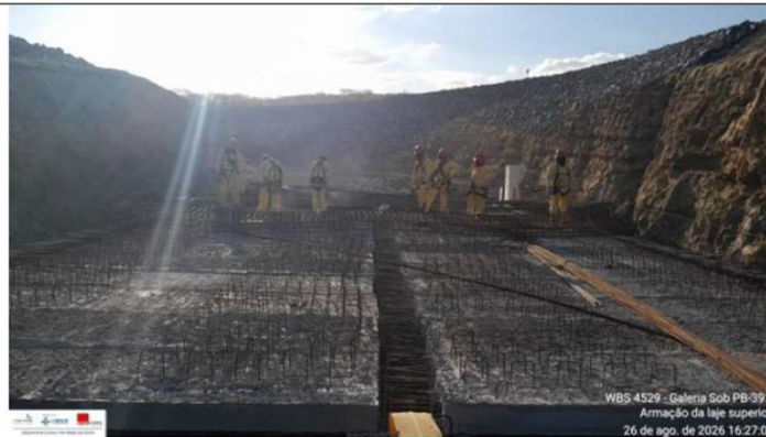
Foto 14: armação da laje superior
