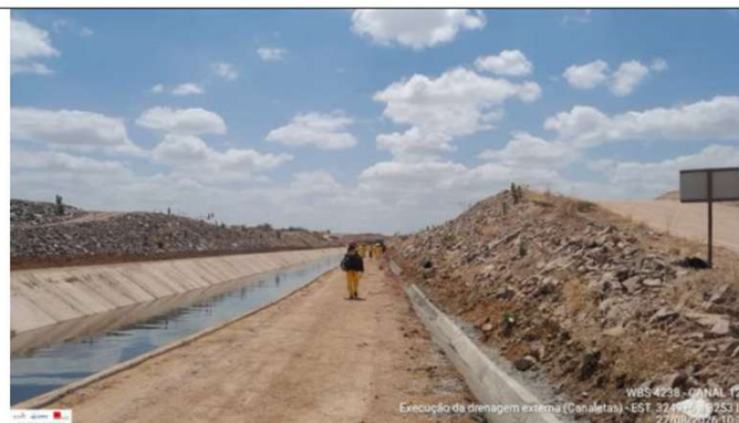
Foto 10: execução de canaleta
