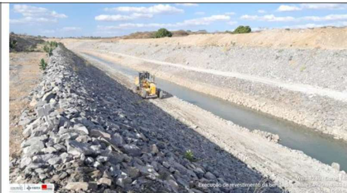
Foto 16: revestimento da berma
