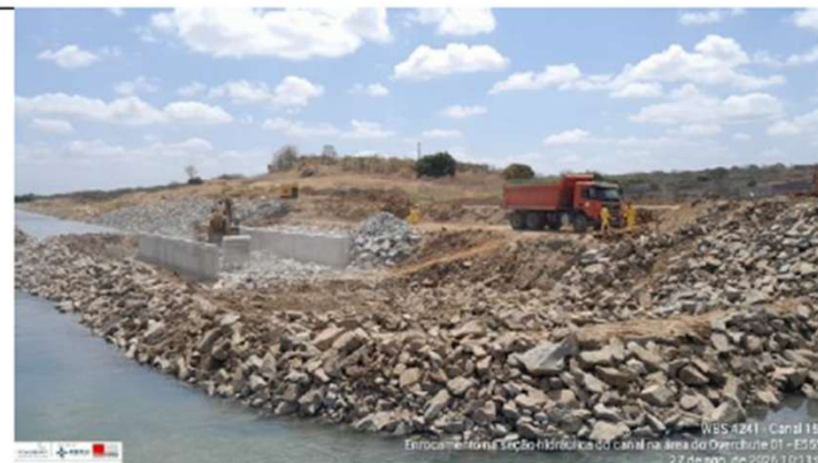
Foto 30: enrocamento na seção hidráulica – Overchute 01
