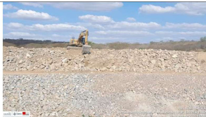
Foto 15: enrocamento de talude externo
