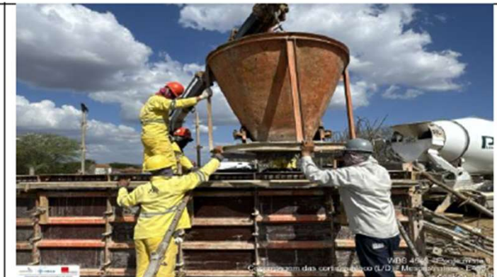
Foto 20: concretagem das cortinas
