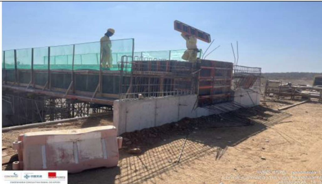
Foto 1: execução das formas e armação
